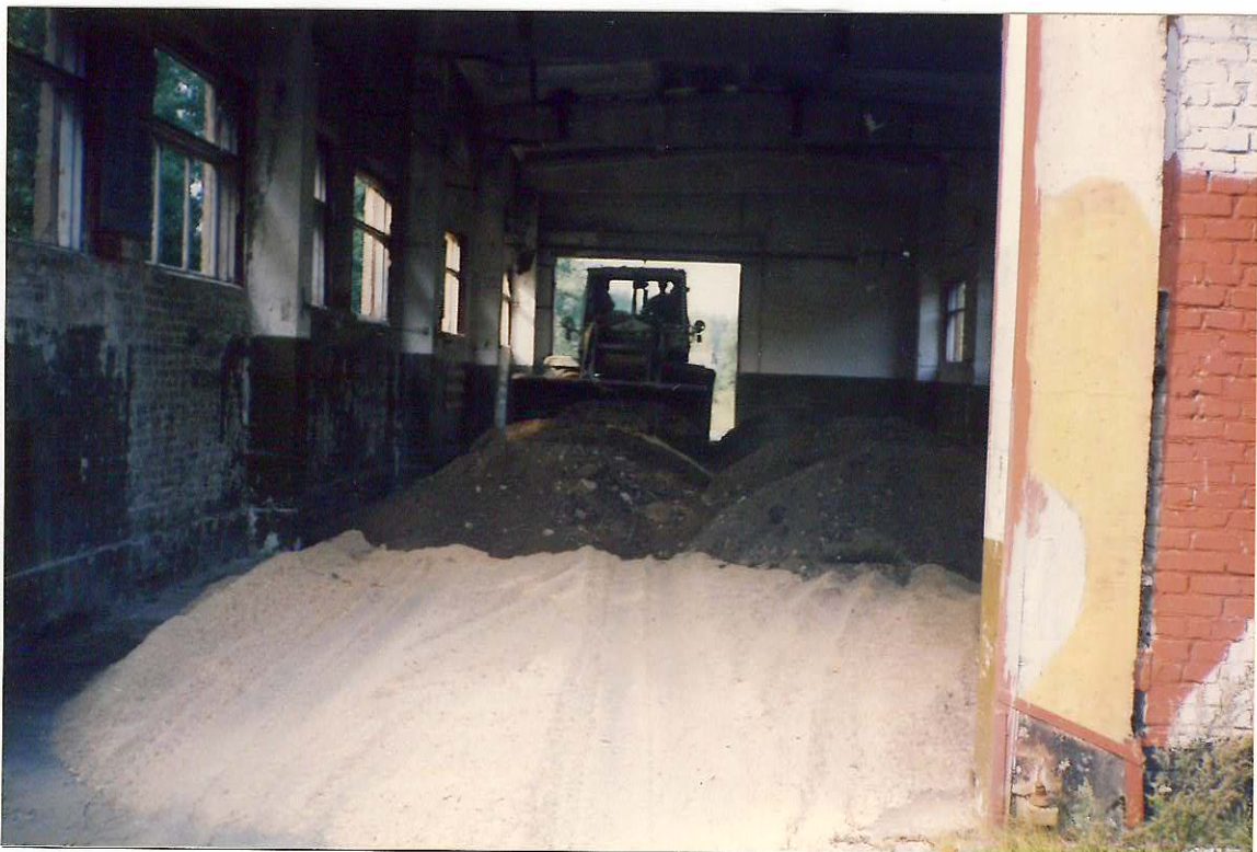
Foto 6. Reostunud pinnase esmane segamine. Fotograaf H. Tang. Foto kuupäev 05.09.1997
