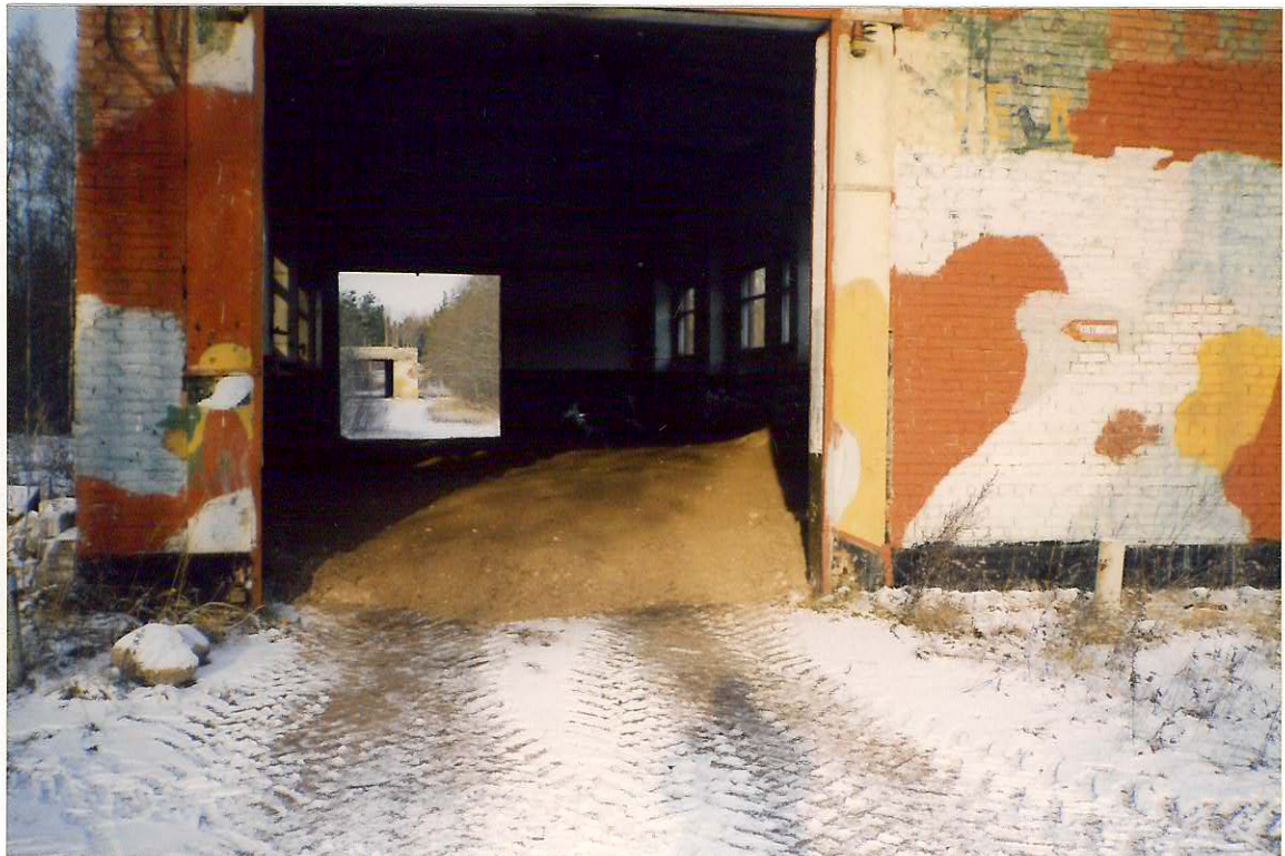
Foto 8. Reostunud pinna 1997. aasta lõpus pärast teist segamist. Puhastatav pinna oli angaaris ca 60-70cm paksuse kihina. Angaari paigutamisega välditi reoainete (samiini) levimist sadevete toimel puhtale alale. Fotograaf H. Tang. Foto kuupäev 05.11.1997
