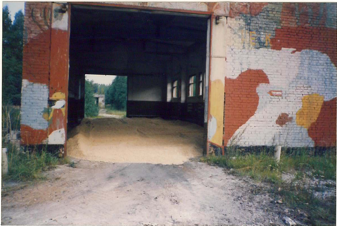
Foto 5. Samiiniga reostunud pinnas paigutati lähedal asuvasse angaari eelnevalt sinna veetud saepuru kihile. Fotograaf H. Tang. Foto kuupäev 20.08.1997
