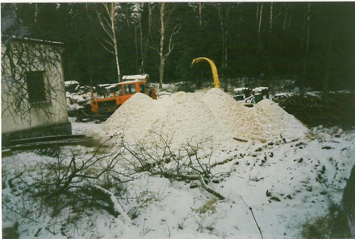
Foto 7 Pinnasesse orgaaniliste lisandite segamiseks valmistati kohapeal hakkepuitu. Fotograaf N. Reinap 10.11.98.a.
