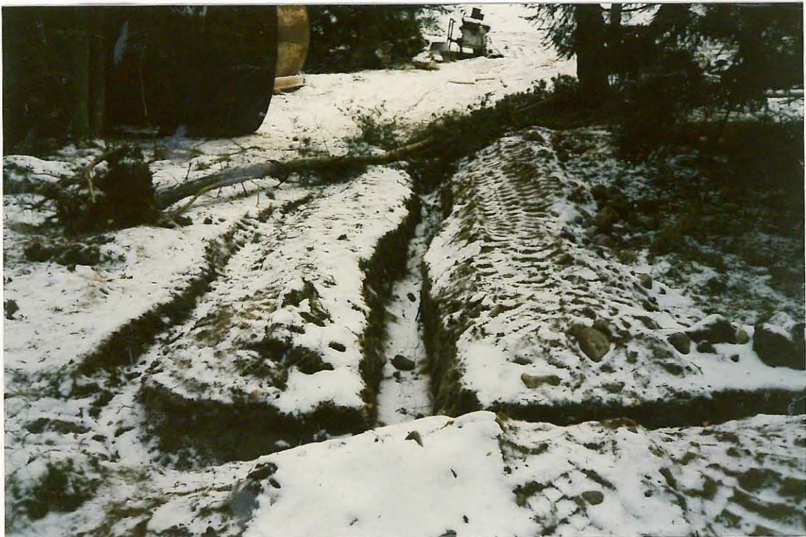
Foto 6 Kaevetööd majaka toitekaabli ümbertõstmiseks reostatud alalt. Fotograaf N. Reinap 04.11.1998.a.
