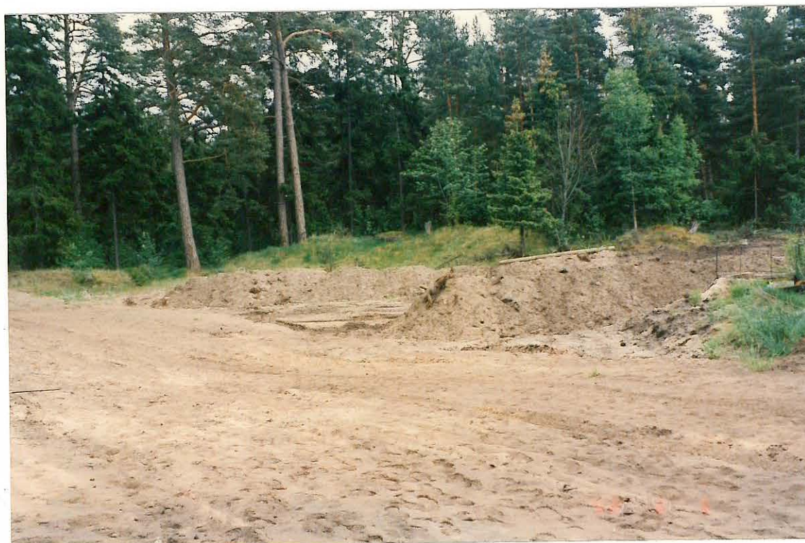
Foto 6 Varem reostatud ja mustunud pinnas on kompostimisega puhastatud määral, mis võimaldab kompostitud pinnast kasutada samas liivikute haljastamiseks. Fotograaf N.Reinap 15.06.99.a.
