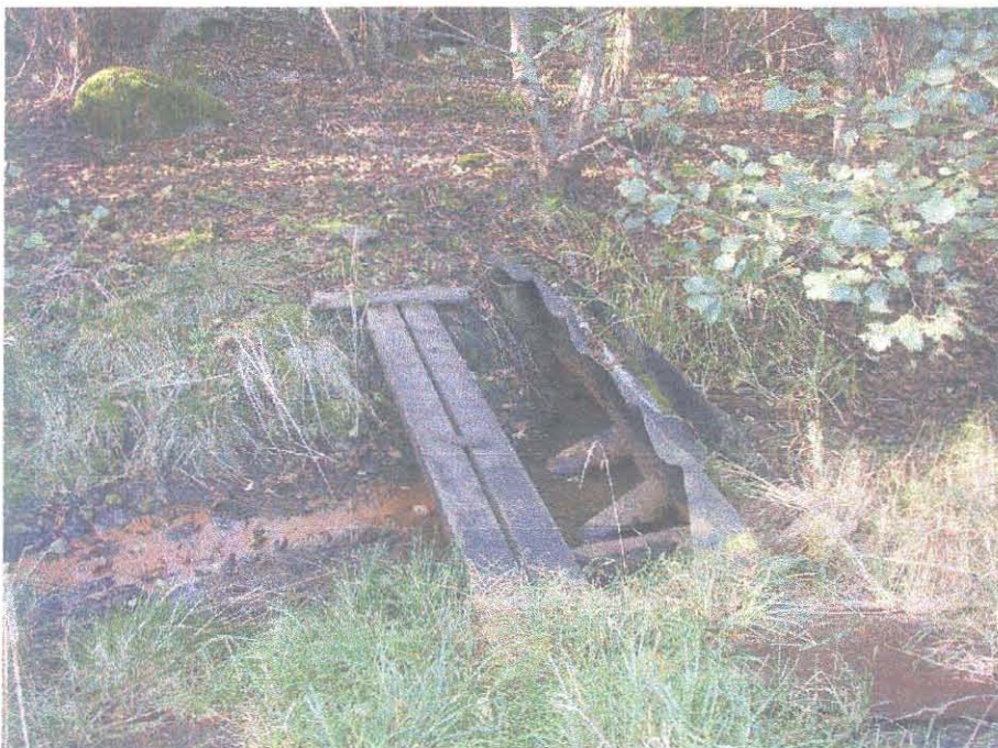
Foto 4. Järjestikusest kolmas õlipüüdja pinnaveekraavil
