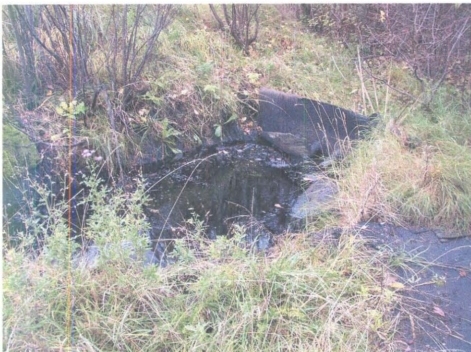
Foto 1. Õlipüüdja taha kogunenud masuut, tegemist on järjestikuliselt esimese õlipüüdjaga
