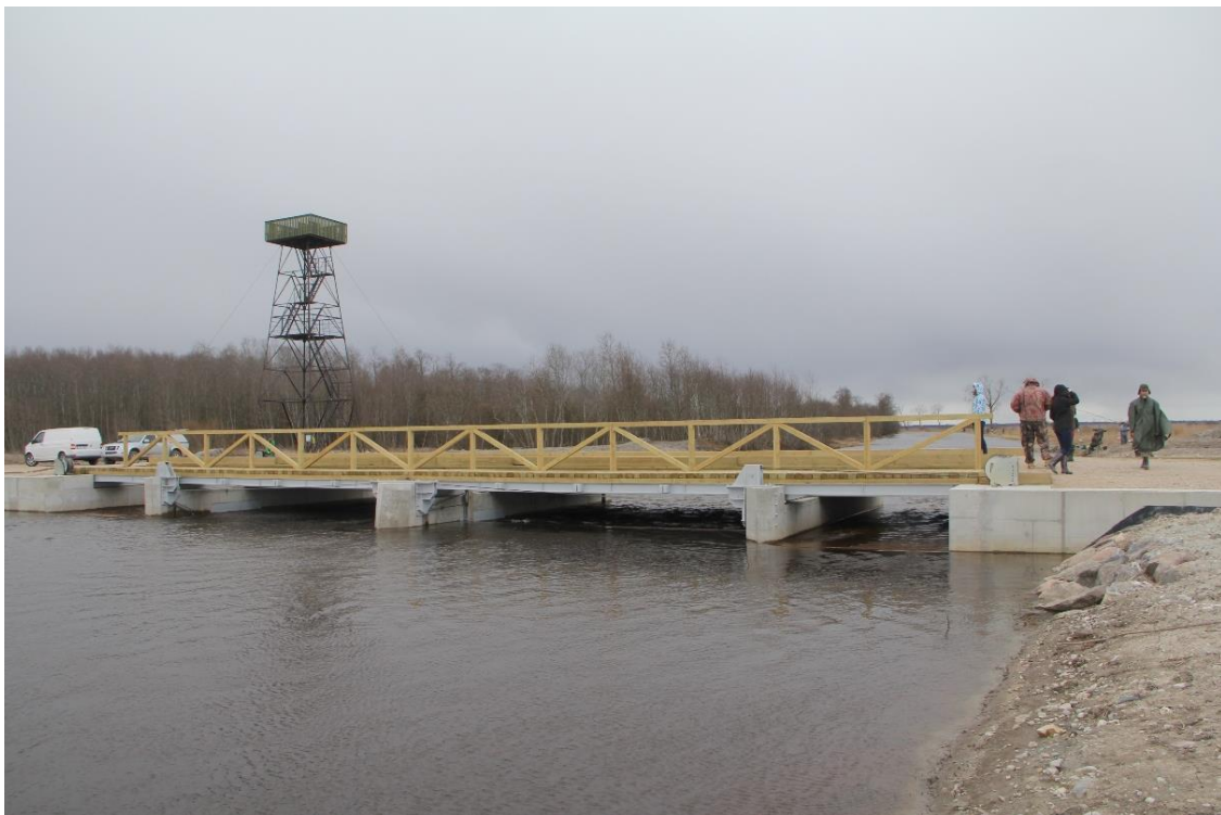
Foto 4 . Renoveeritud Kloostri sild (16.04.2015). Silla all on vool kiire, ent kaladele see olulist takistust ei kujuta. Pigem on probleemiks see, et äärmistes alati lahti olevates vahedes peavad kalad ujuma õhukeses pinnakihis ning takistuse äär on järsk ning kõrge, mitte looduslähedaselt lauge.
