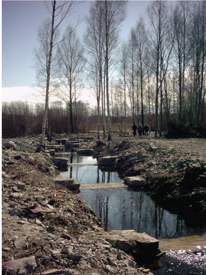
Foto 21. Järveküla järvede ja Võlupe jõe vaheline kalapääs pärast valmimist 2002. aastal. Pilt on tõenäoliselt tehtud kevadise suurvee ajal.
