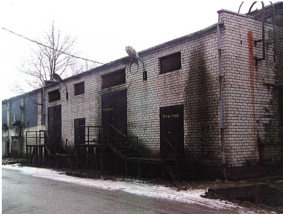
Foto 2 Trafo-alajaam Sepise tn 10
