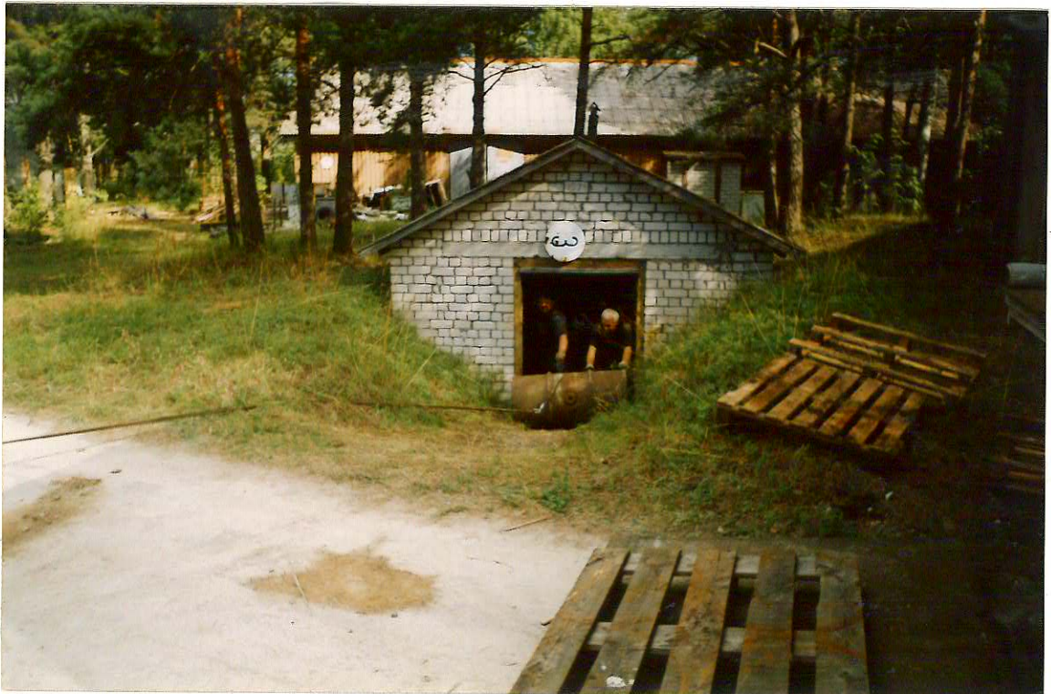
Foto 8 Täiendava tööna puhastati ka kõik hooned ja keldrid ohtlikest jäätmetest. Fotograaf O. Silla 15.08.2001.a.
