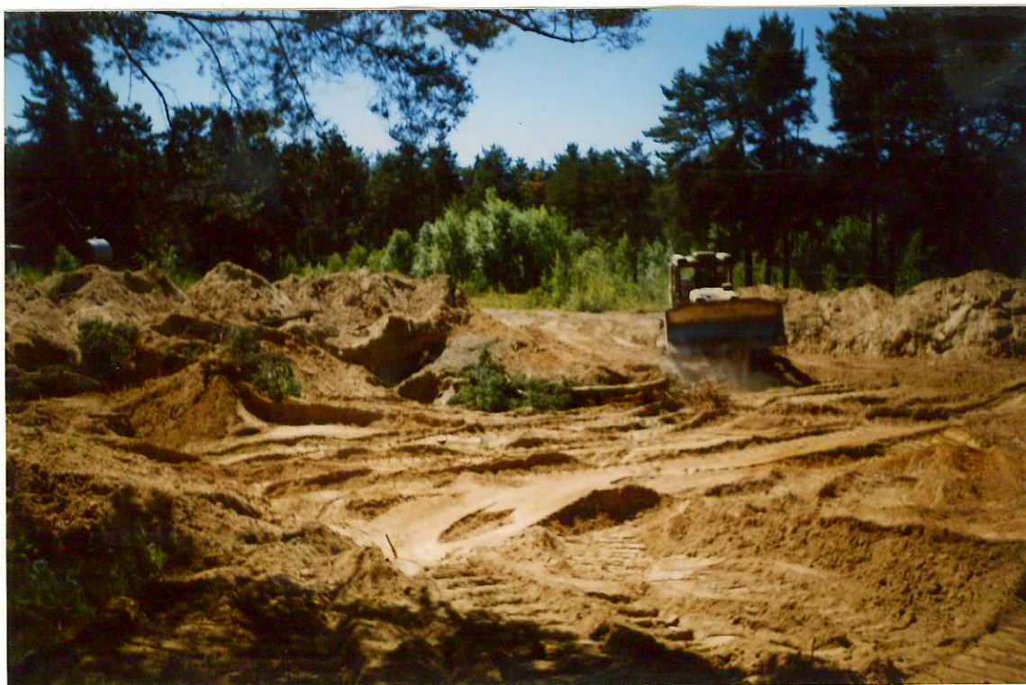
Foto 4 Kaevete tasandamine buldooseriga. Fotograaf O. Silla 25.07.2001.a.
