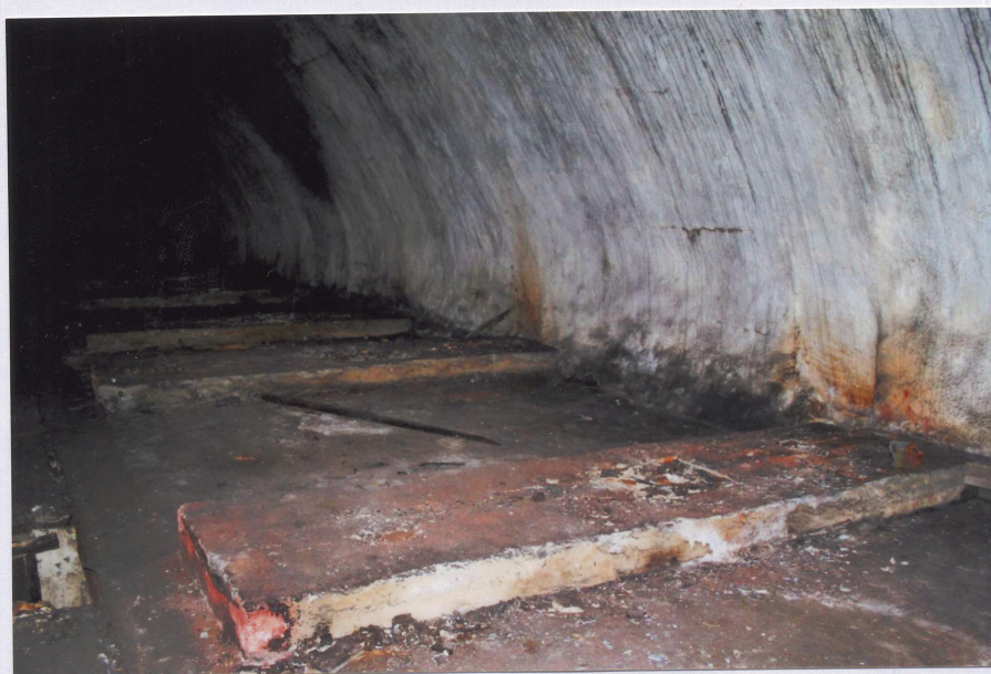
Foto 20. III U-kujulise tunneli betoonist põrand (Betonist alused ja vasakul raudtee jälg)
