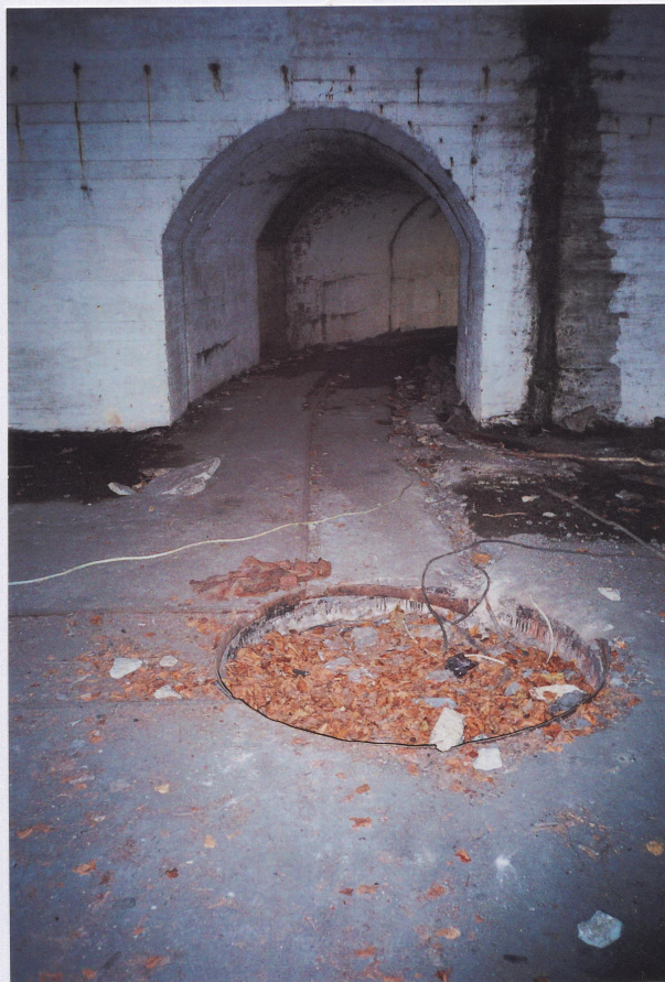
Foto 19. Kagupoolsem sissepääs III tunnelisse (Ringikujuline raudtee- pöörang, tee pöörduv vasakule)
