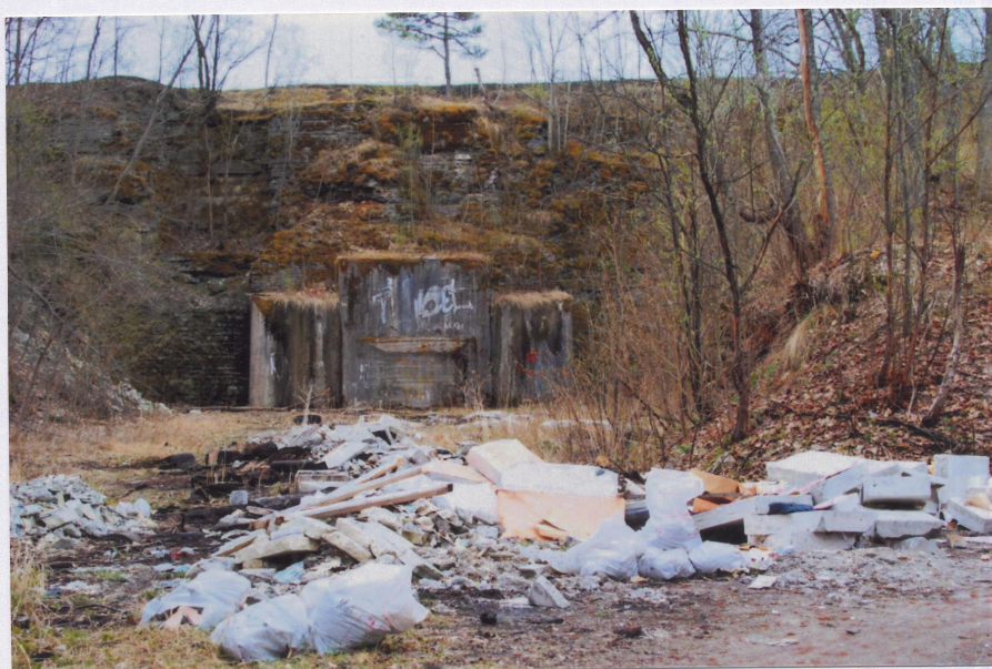
Foto 12. I tunneli loodepoolsem sissekäik
