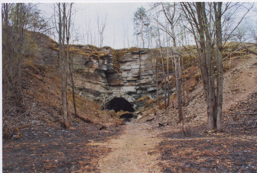
Foto 15. II tunneli kagupoolsem sissekäik
