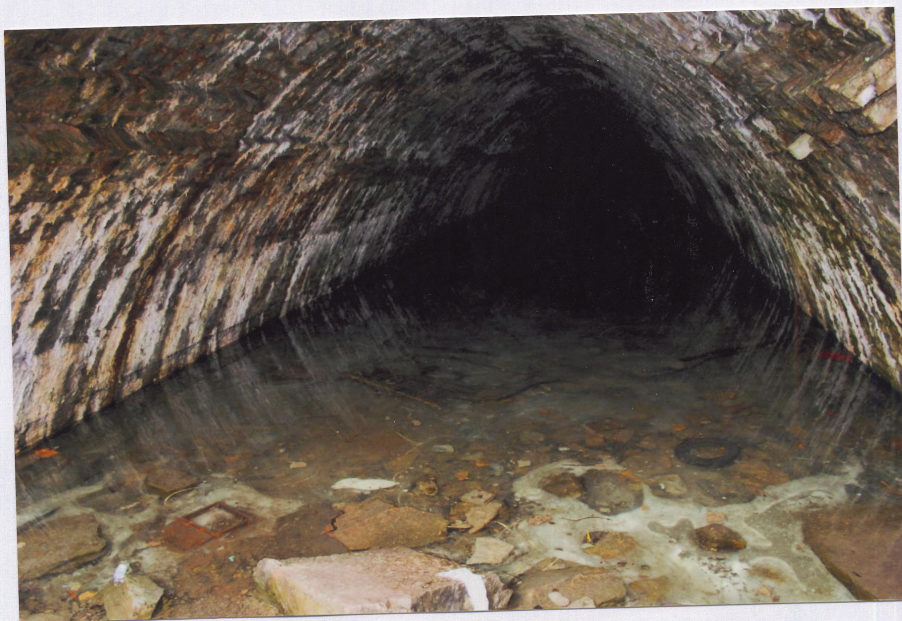
Foto 21. II U-kujulise tunneli kagupoolsem sissepääs (põhja katab vesi, seinad ja lagi betoneeritud)
