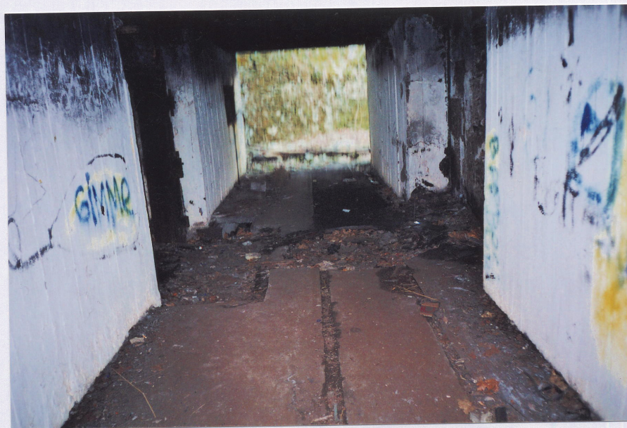
Foto 17. Loodepoolsem sissepääs I tunnelisse (Ringikujuline raudteepöörang, tee pöördub paremale)
