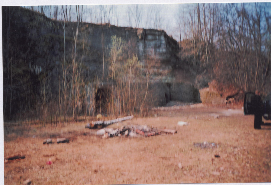
Foto 14. III tunneli loodepoolsem sissekäik
