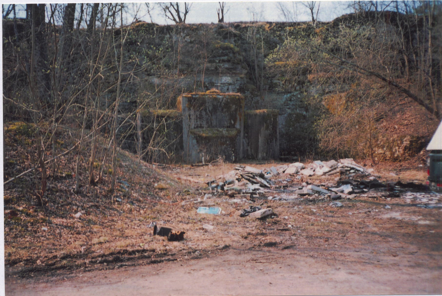
Foto 11. I tunneli kagupoolsem sissekäik
