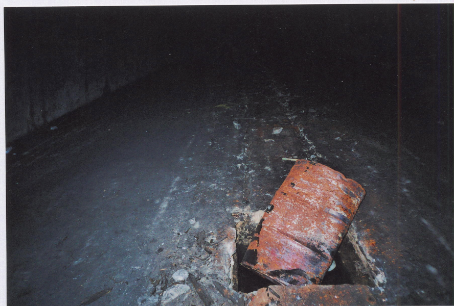
Foto 18. I tunneli betoonist põrand (Raudtee jälg ja betoneeritud drenaažitoru teeninduse kaeve)
