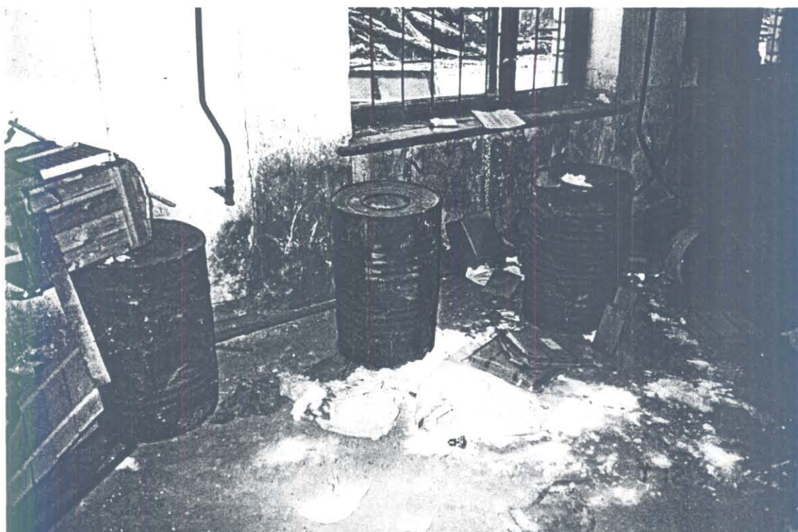
Foto 4. Tünnid kaltsiumtsüaniidi ja kaltsiumkarbiidi seguga. (Töökoda) Fotograaf T.Lambut. Foto kuupäev 07. 12. 1995.a.
