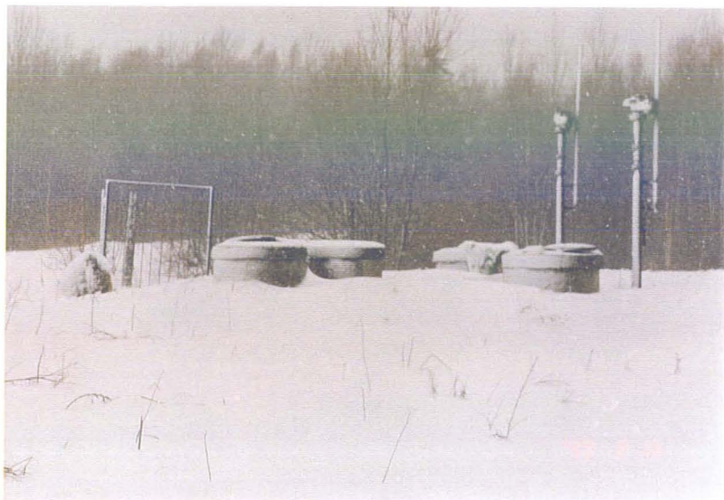
Foto 5. Vaade jääktühjenduse mahutitele (2 tk. a' 50 m 3 , nr. 319 B)
