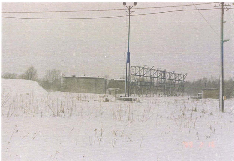
Foto 1. Vaade 2 tk. a' 1000 m 3 mahutitele (nr. 319) ja estakaadile (nr. 321). Fotol paremal pumbajaam (nr. 319 A)
