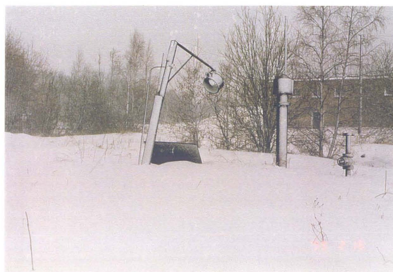
Foto 4. Vaade 200 m 3 masuudi vastuvõtu maa-alusele mahutile (nr. 319 B)
