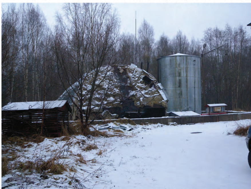
Foto 15 Puiduimmutustehase mahutipark, suurem mahuti on osaliselt lammutatud.JPG
