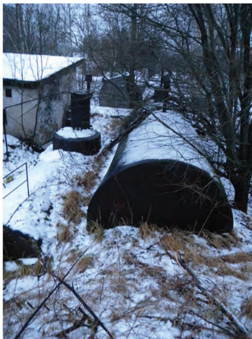
Foto 01 Hüljatud mahutid Turba elektrijaama juures.JPG
