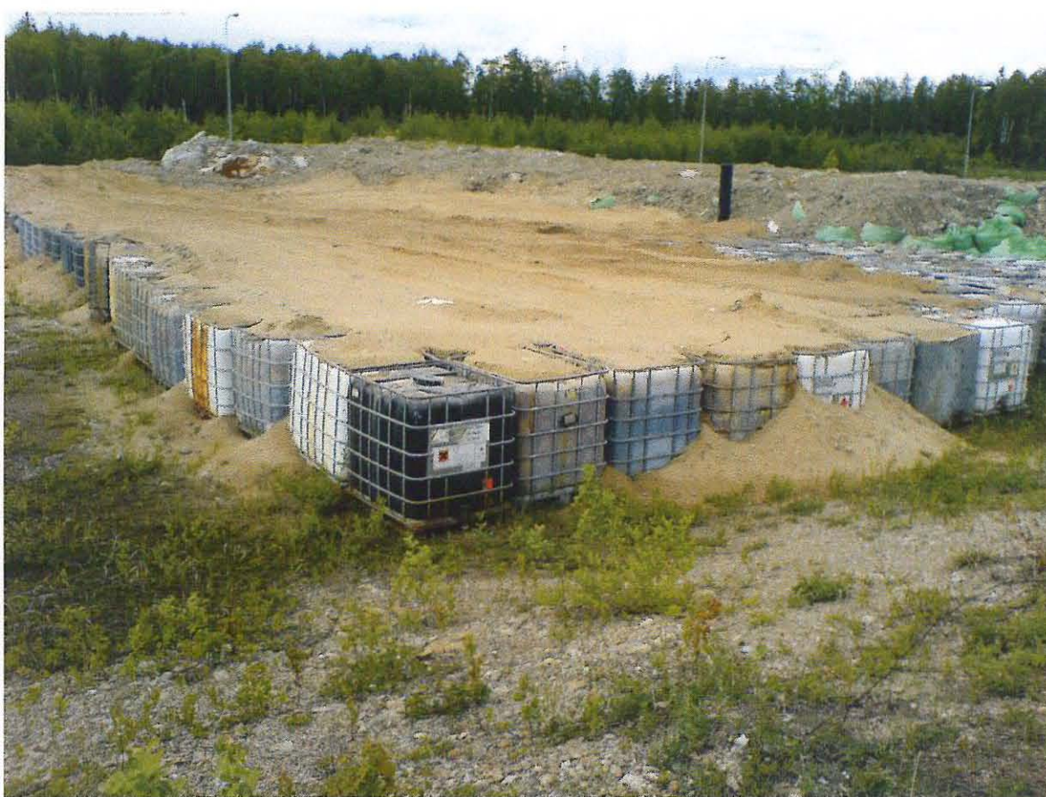
Töödeldud ja tahkestatud arseeni jäätmete ladestamine
