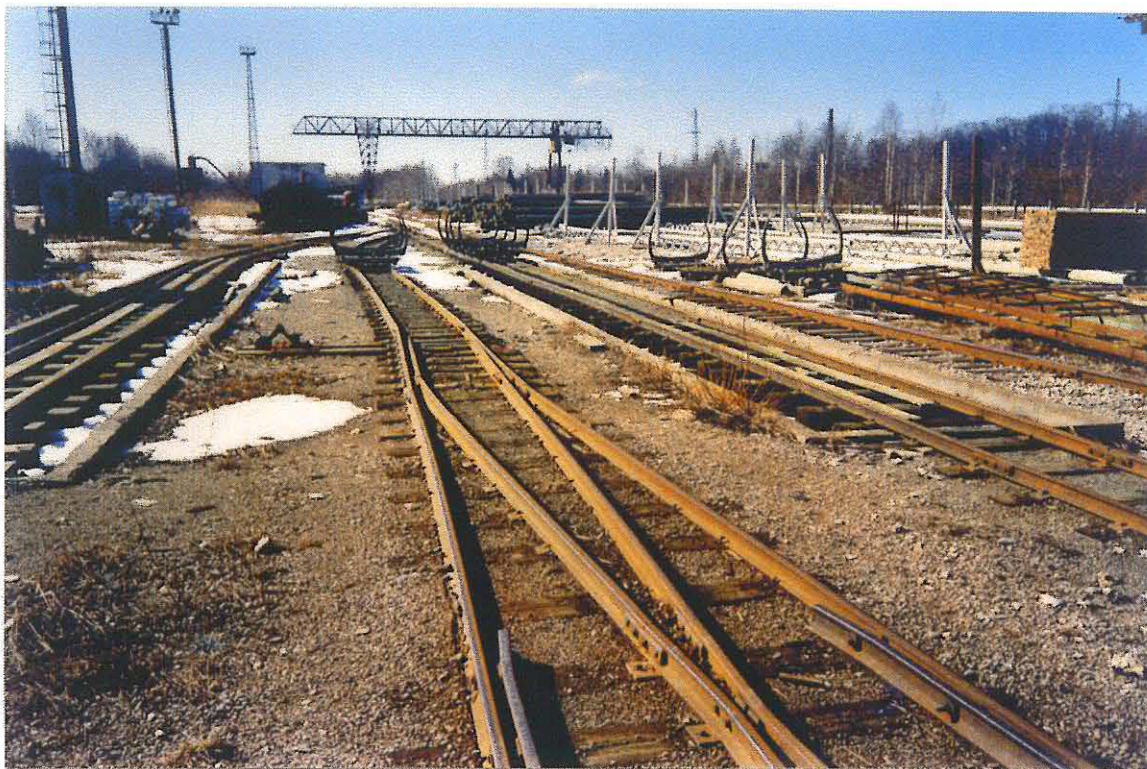
Endise puiduimmutustehase laadimisplats
