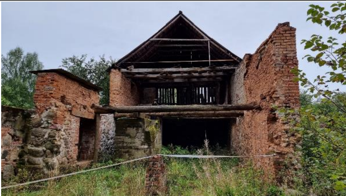
Pilt 15. Hellenurme vee jõul töötanud saeveski varemed. Vaade kirdest. Foto: Mart Hiob 2021.
