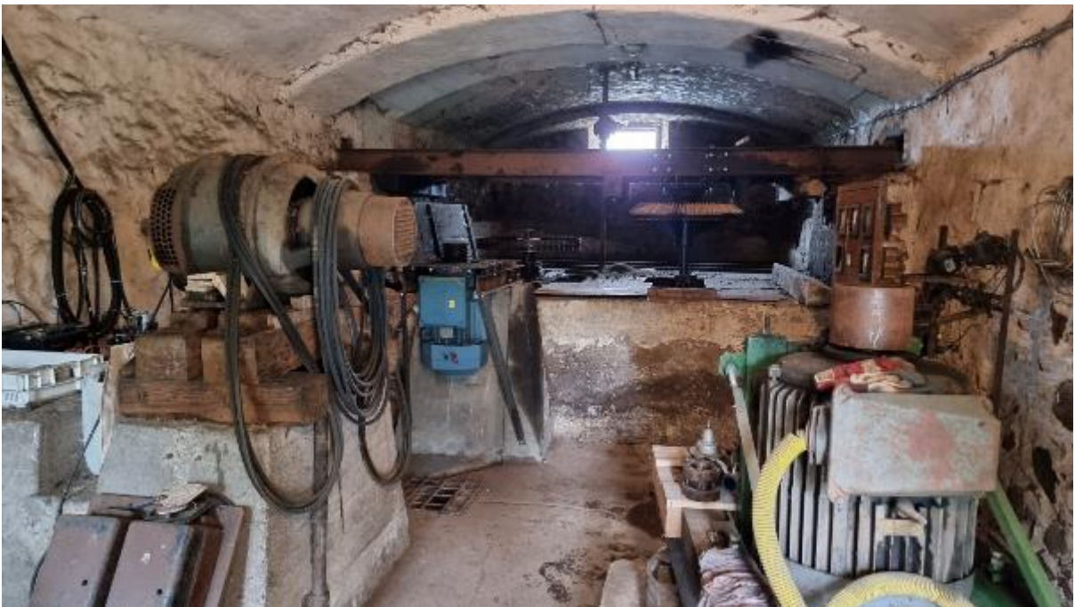
Pilt 18. Hellenurme vee jõul töötava jahu- ja püüiveski ning elektrijaama turbiiniruum. Hammasratasülekanne käivitab veski ja turbiini rihmarattalt käivitab elektrigeneraatori turbiin. Mõlemad saavad töötada samaaegselt. Foto: Mart Hiob 2021.
