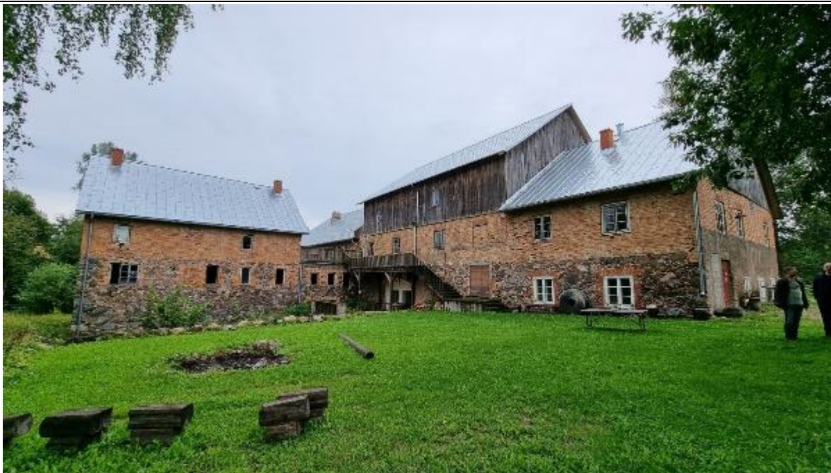
Pilt 11. Hellenurme vee jõul töötav jahu- ja püüiveski, samuti väike elektrijaam. Vasakul moonakate majatiib, paremal veski. Vaade hoovist, põhjast. Foto: Mart Hiob 2021.
