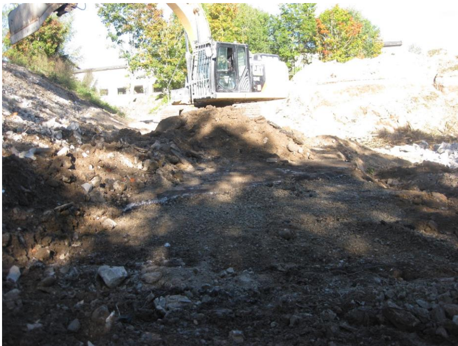
Foto 23 Mahutihoone ees oleva reostunud pinnase eemaldamine
