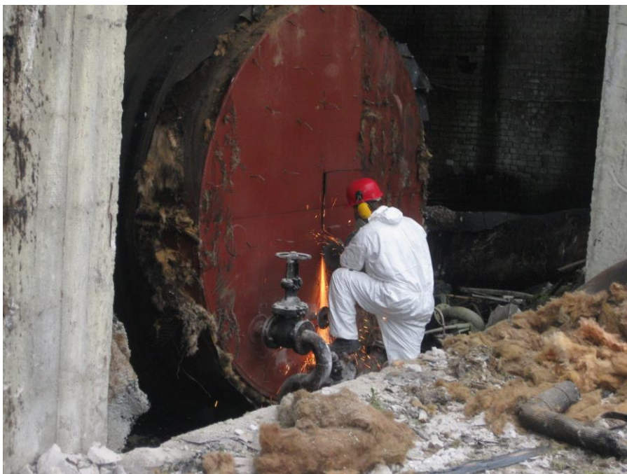
Foto 4 Mahutite avamine vedelate jäätmete eemaldamiseks
