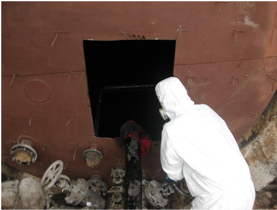
Foto 5 Mahutist vedelate jäätmete eemaldamine
