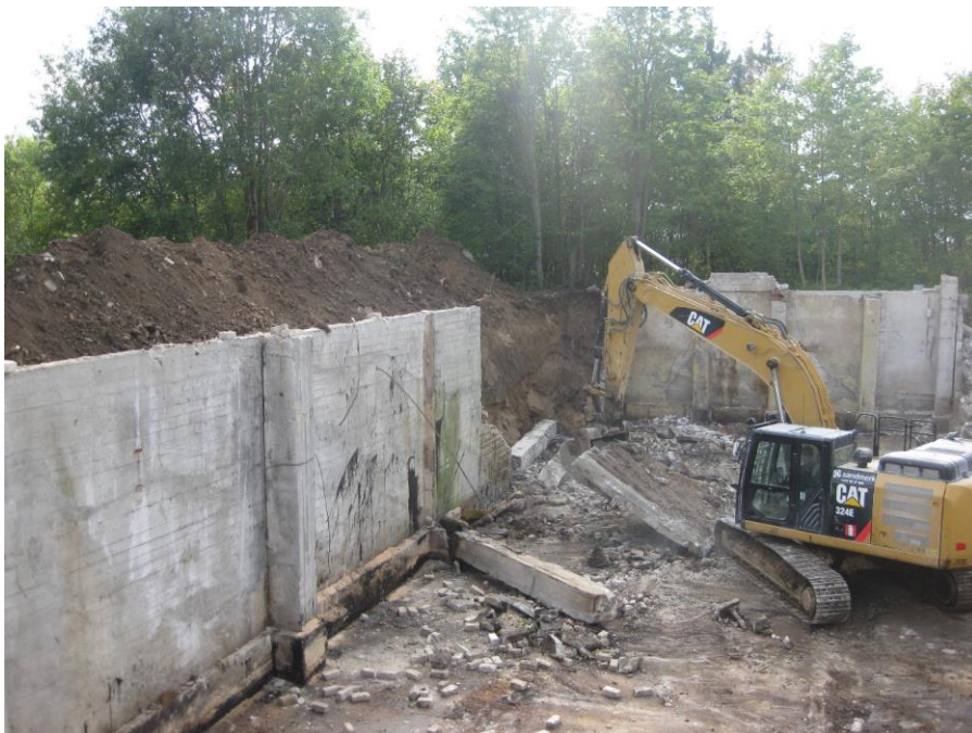
Foto 19 Mahutihoone tagaseina eemaldamine
