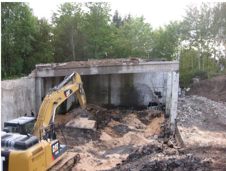
Foto 14 Mahutihoone põranda puhastamine
