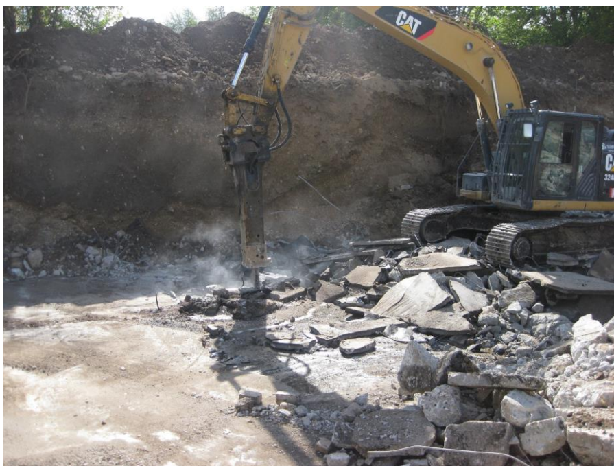
Foto 20 Masuudihoone põranda eemaldamine
