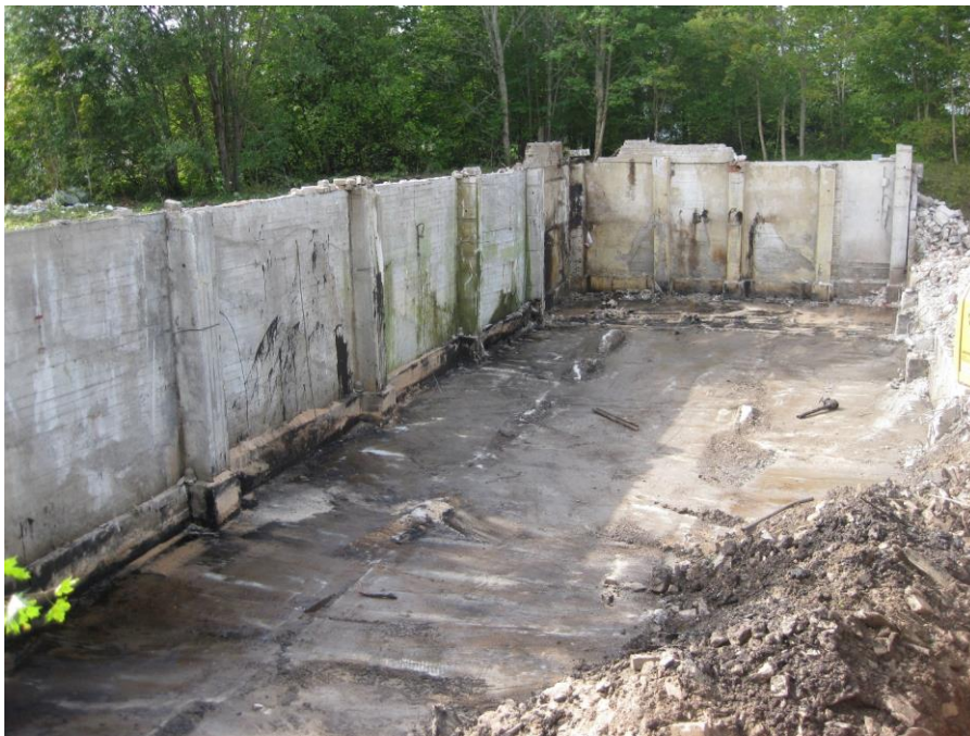
Foto 16 Puhastatud põhjaga mahutihoone
