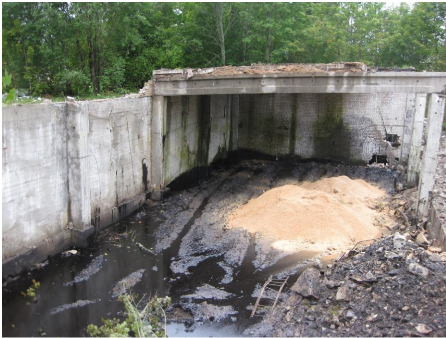
Foto 13 Saepuru sissevedu mahutihoone põrandal oleva püdelate masuudijäätmete kokku korjamiseks
