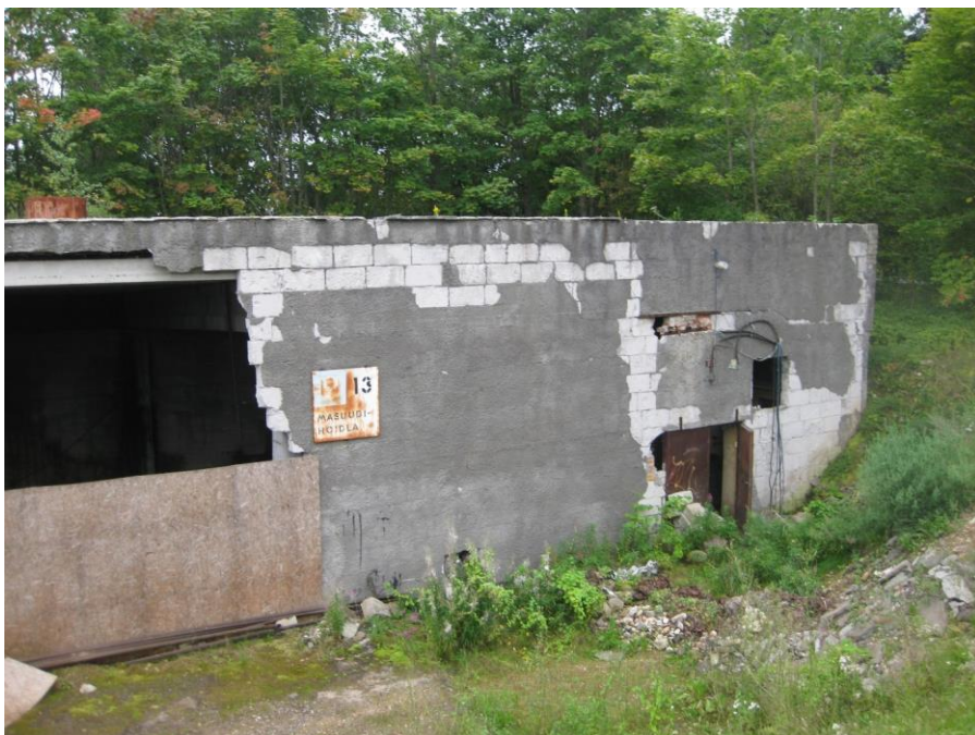
Foto 1 Maduudihoon esikülg enne lammutust
