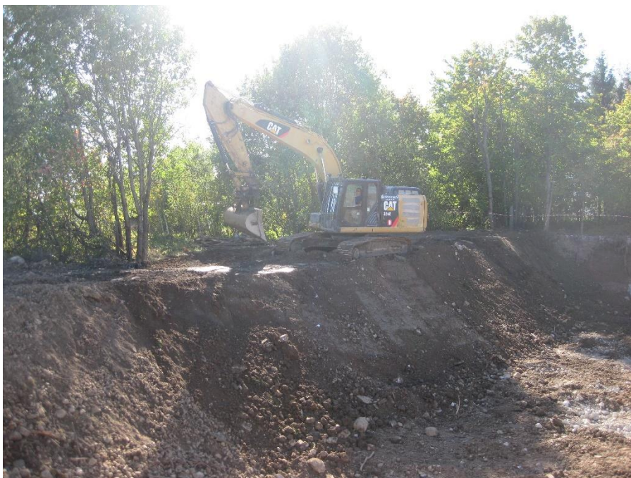
Foto 24 Vertikaalplaneerimine ja nõlvuste loomine
