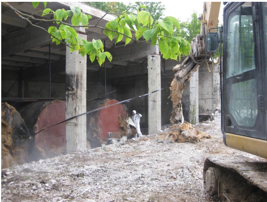
Foto 3 Mahutitelt asbestisolatsiooni eemaldamine
