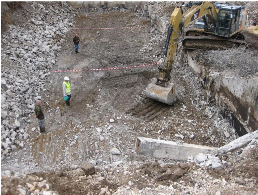
Foto 22 Pinnaseproovide võtmine. Põhi on jagatud kolmeks sektsiooniks.
