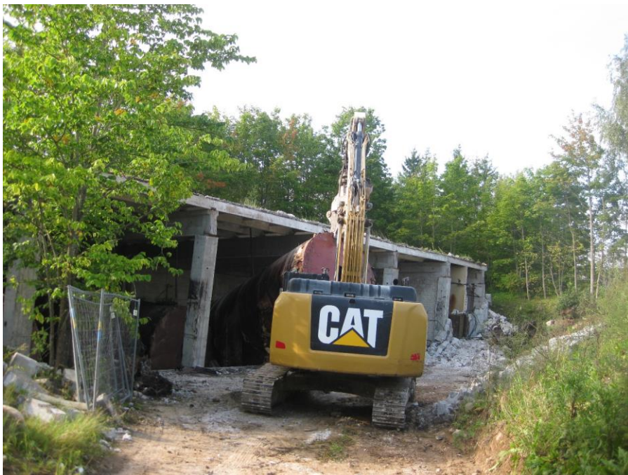
Foto 6 Mahutite eemaldamine hoonest
