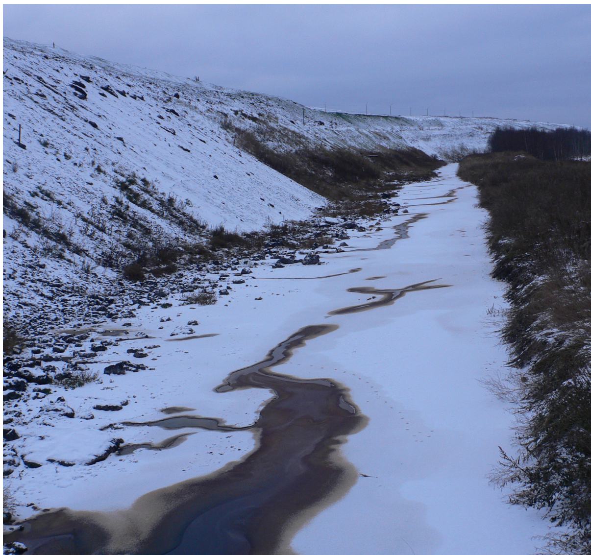
Foto 20 Poolkoksiladestu lääneosa nõrgvee kraav, november 2007
