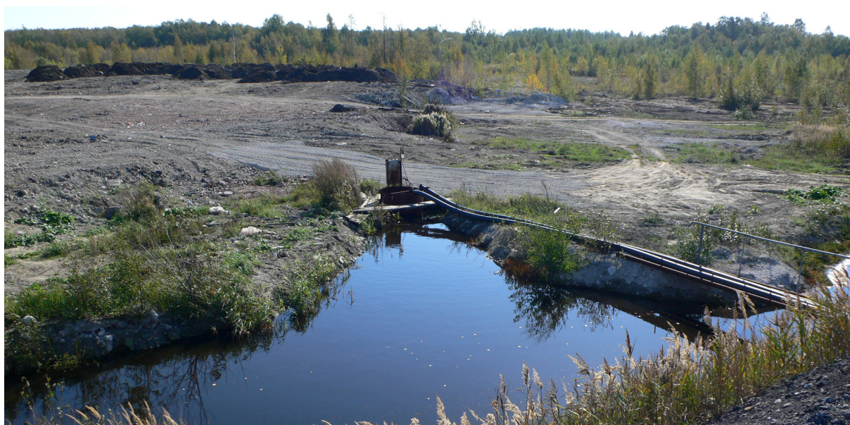
Foto 21 Täiendav pumpla piirdekraavil pumplast 5 läänes, juuni 2006 (vesi poolkoksiladestu edelaosas paiknevasse basseini)
