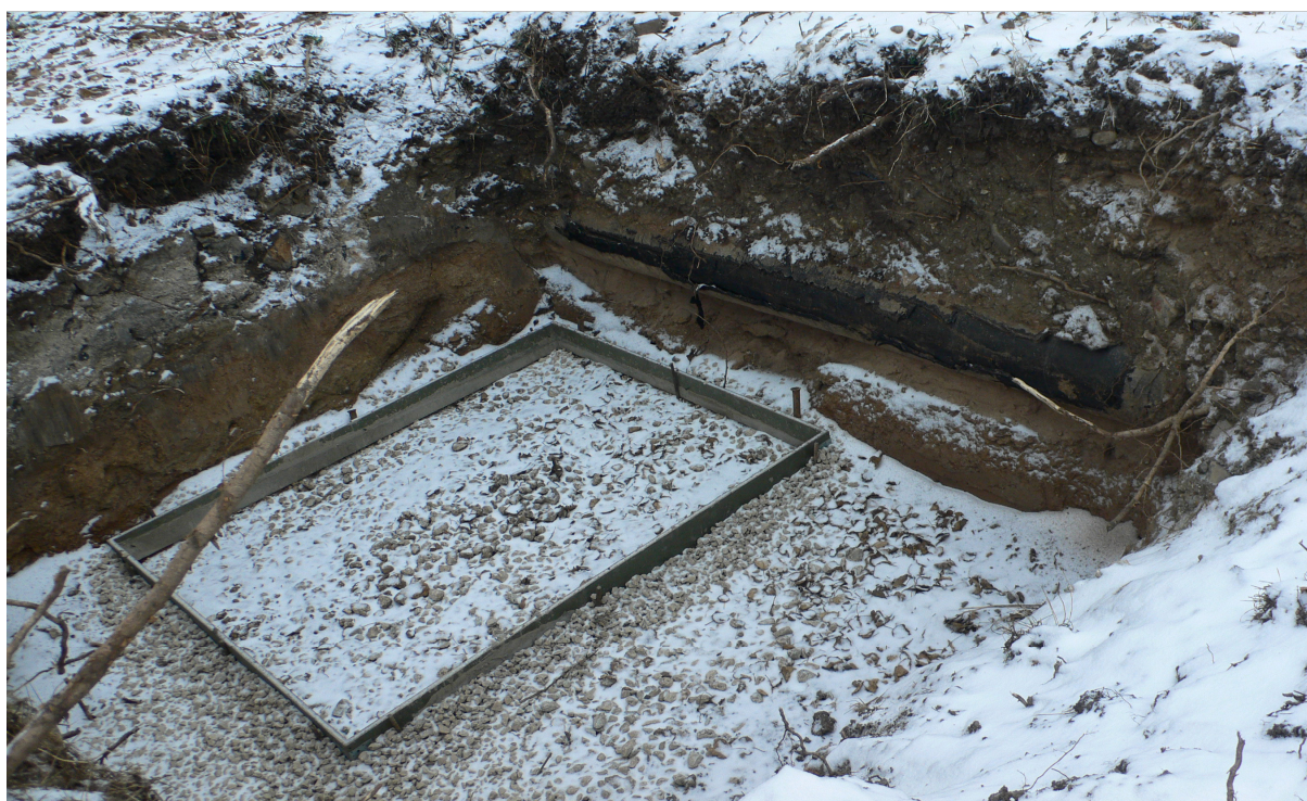
Foto 8 Uue õlitehase ühe tugiposti vundamendiauk torustiku kõrval, november 2007
