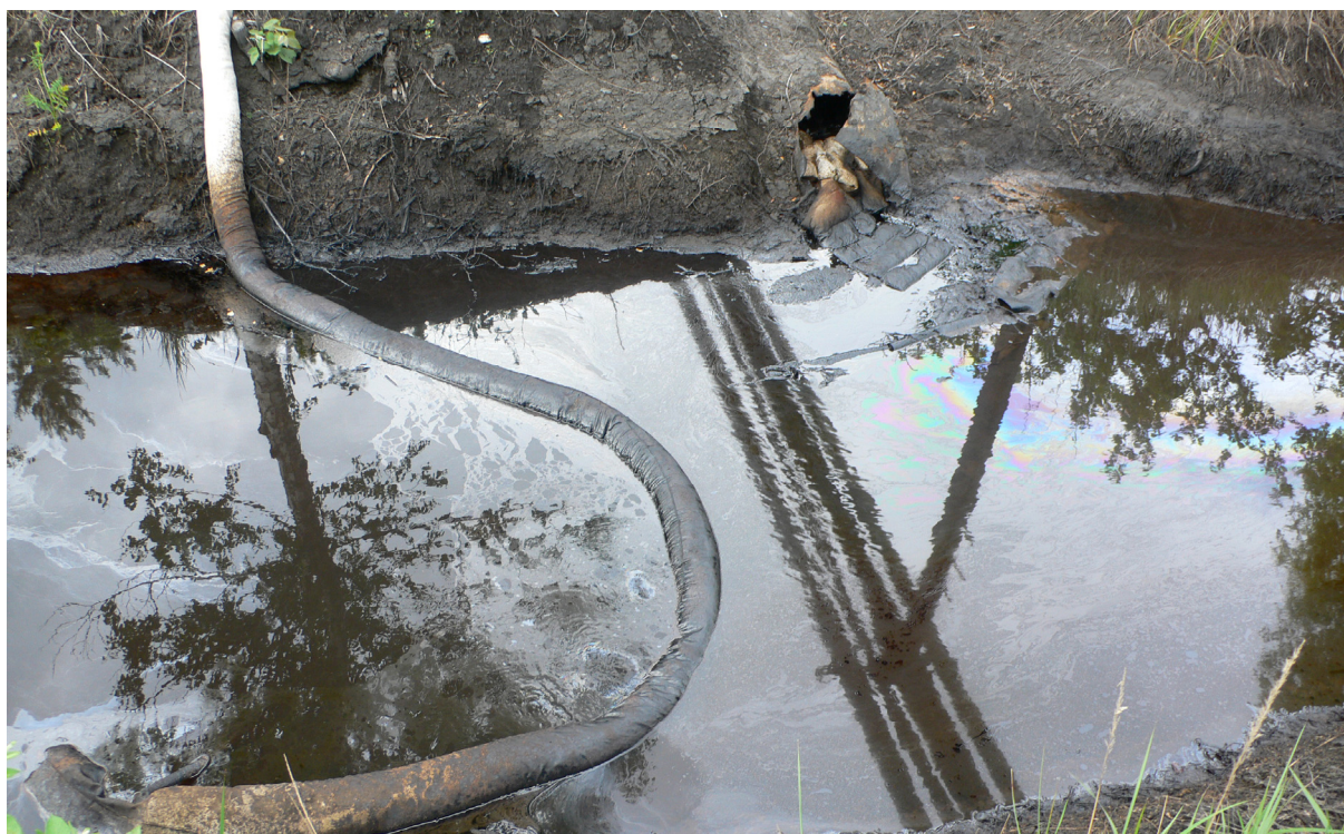
Foto 6 Kraavid tootmisterritooriumil, õlipontoon ja vana toru kraavi, juuni 2007
