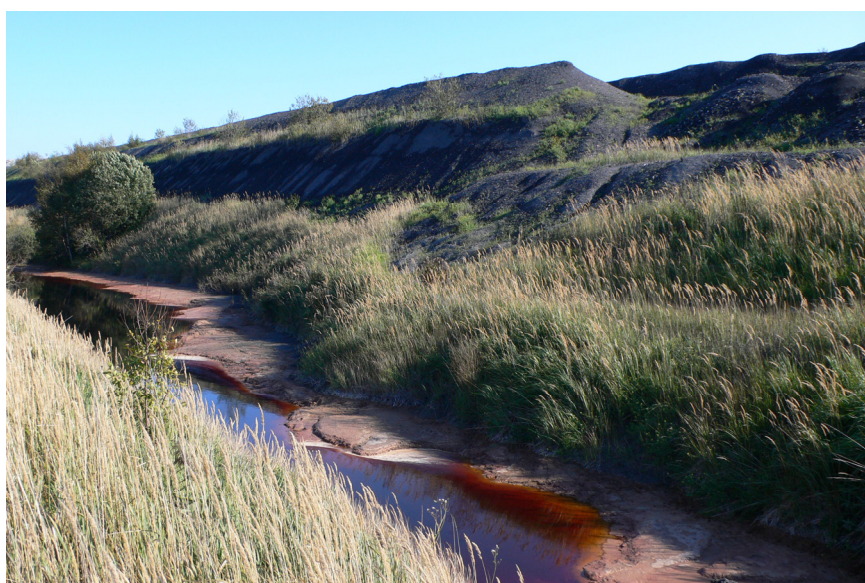
Foto 18 Poolkoksiladestu kraav maalihkekohas vajab puhastamist, juuni 2007
