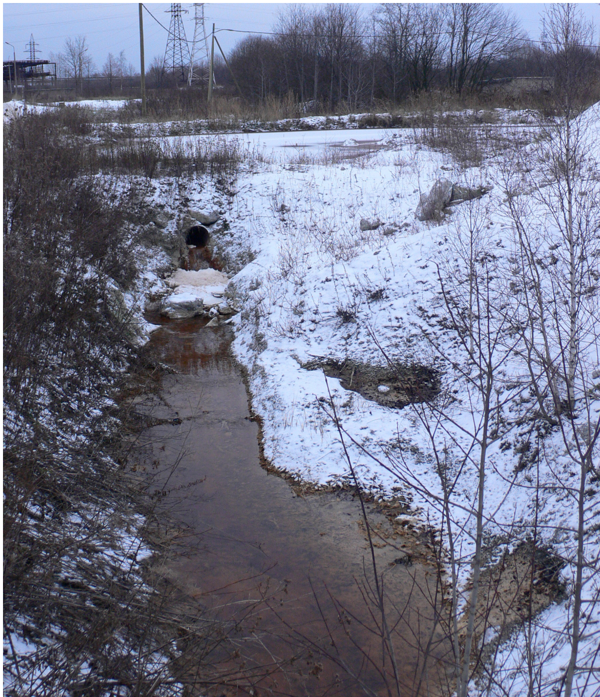
Foto 19 Tuhaladestu piirdekraav ala põhjapoolses kirdeosas, truur reguleerib veetaset tuhaladestu ida-kirdepoolses piirdekraavis, november 2007
