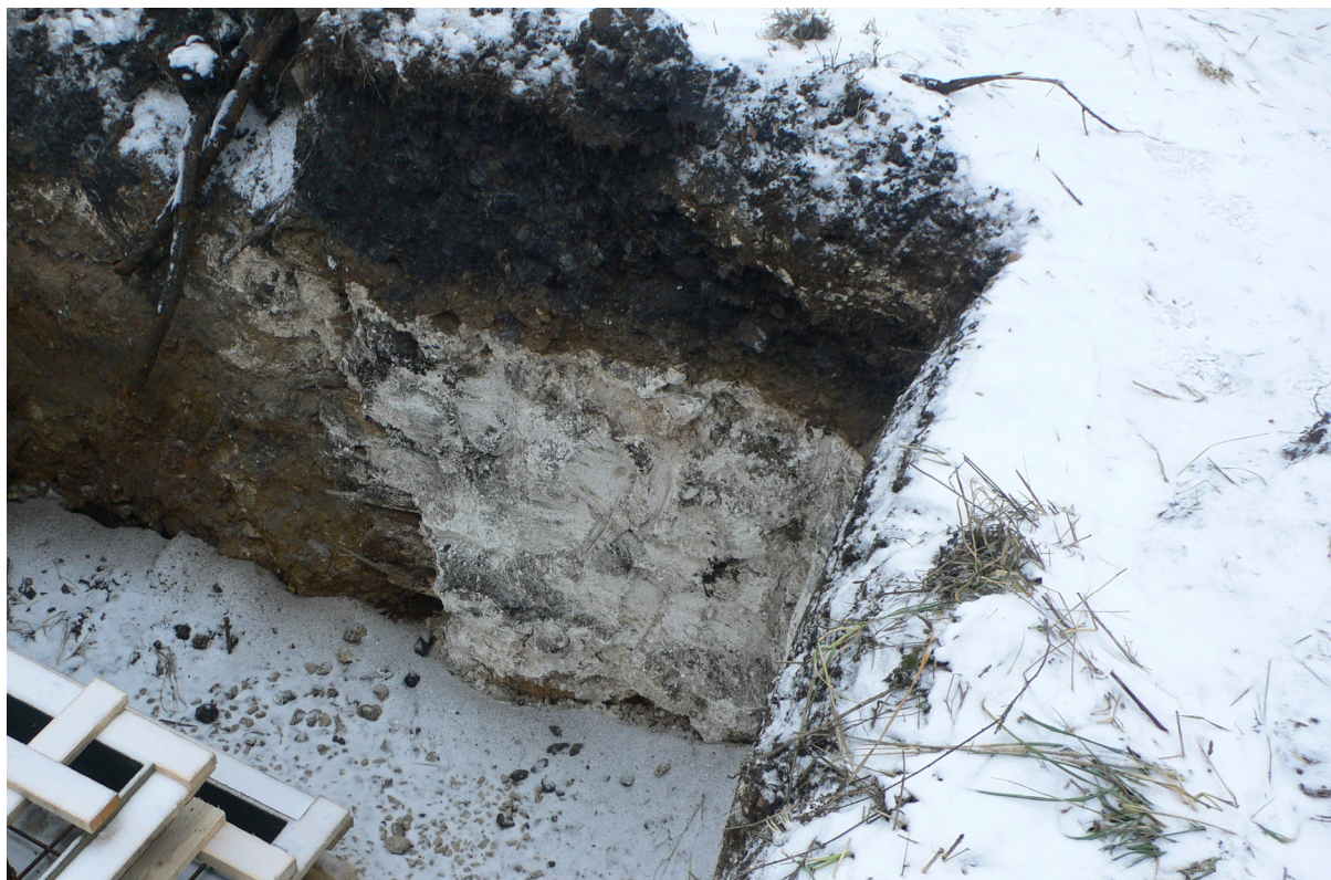
Foto 7 Uue õlitehase ühe tugiposti vundamendiauk, november 2007
