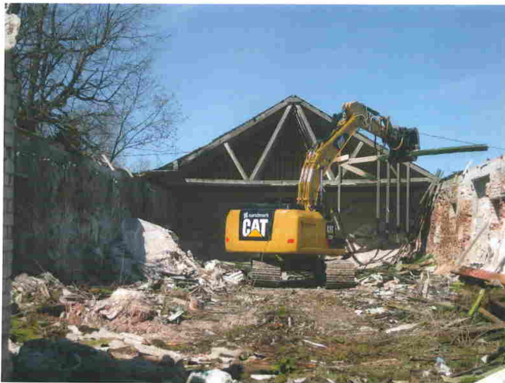
Foto 2 Hoone puitkonstruktsioonide lammutamine haaratskopaga
