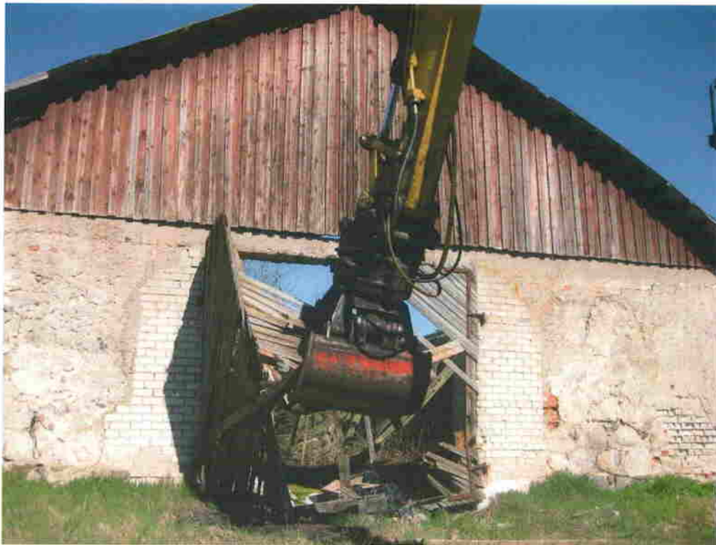
Foto 1 Hoone puitkonstruktsioonide lammutamine haaratskopaga
