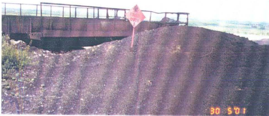
Pilt 1. Estakaad, kust kallurid kallutavad fuusid järve
