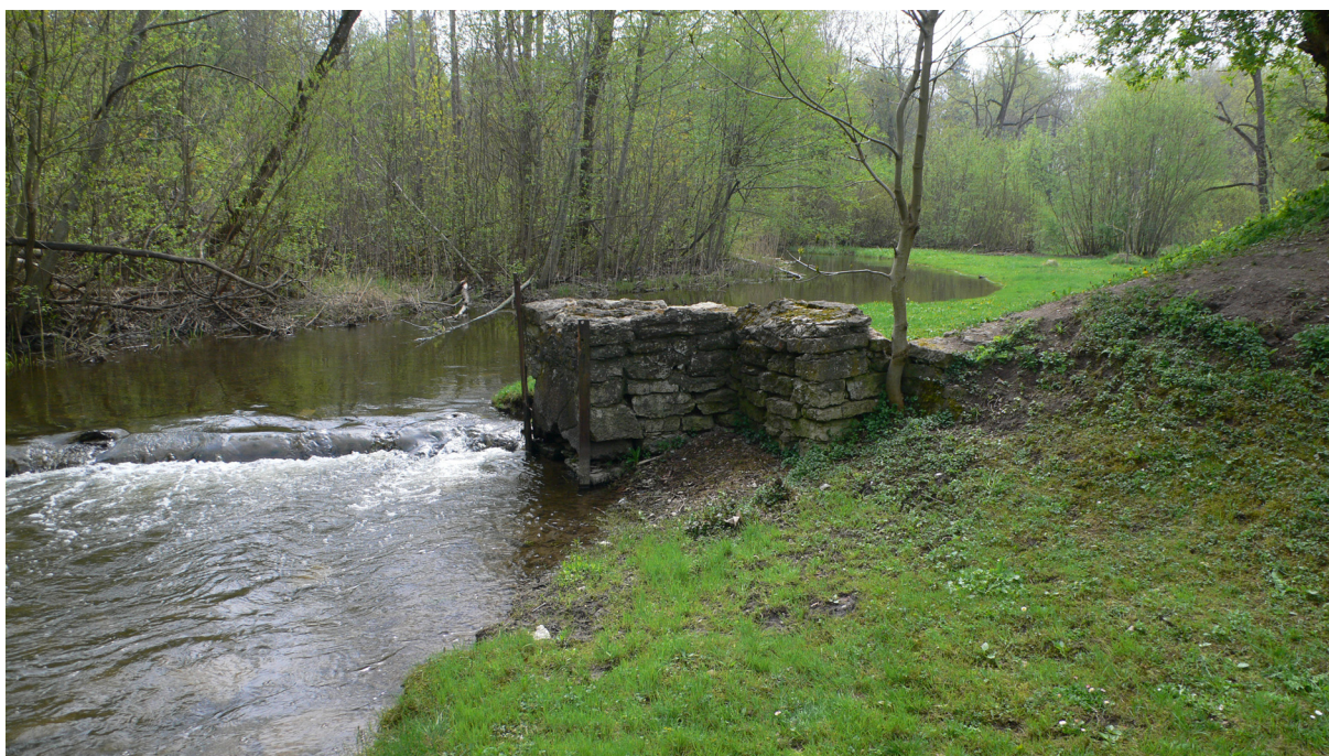
Foto 13 Lüganuse koolimaja juures (K3) on Kohtla jõe ilmselt puhastatud ning vasakpoolset kallast korrastatud
