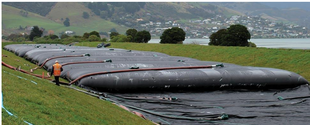
Joonis 4.3.1. Setete pumpamine geotekstiilist tuubidesse (ing k geotube ; allikas: https://www.geobera.com/urunler/geotube/ ).
