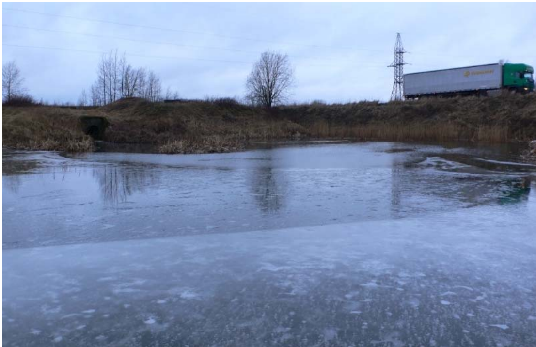
Foto 5. Maardu tööstusrajooni sademe ja heitvee ühisvoolse kanalisatsiooni väljalask alumises tiigis (väljalasu kood TL047).
