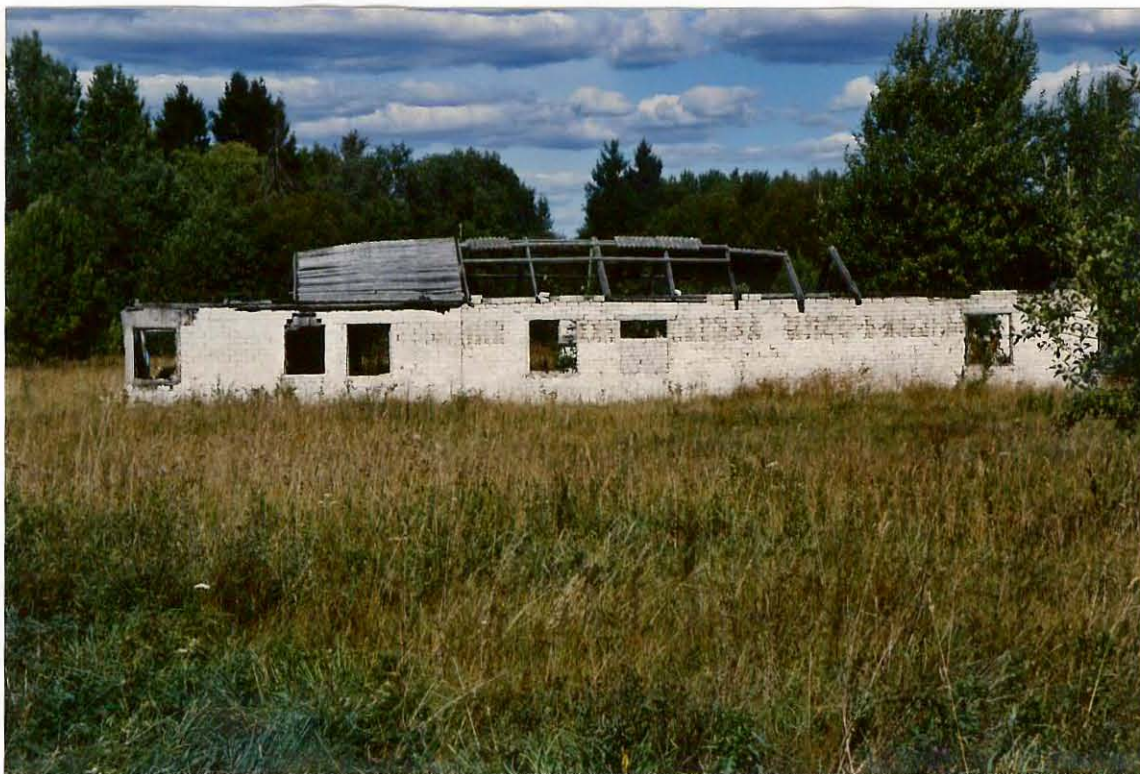
Foto 9 Lammutamisele minev hoone. Fotograaf N. Reinap 17.09.2001.a.
