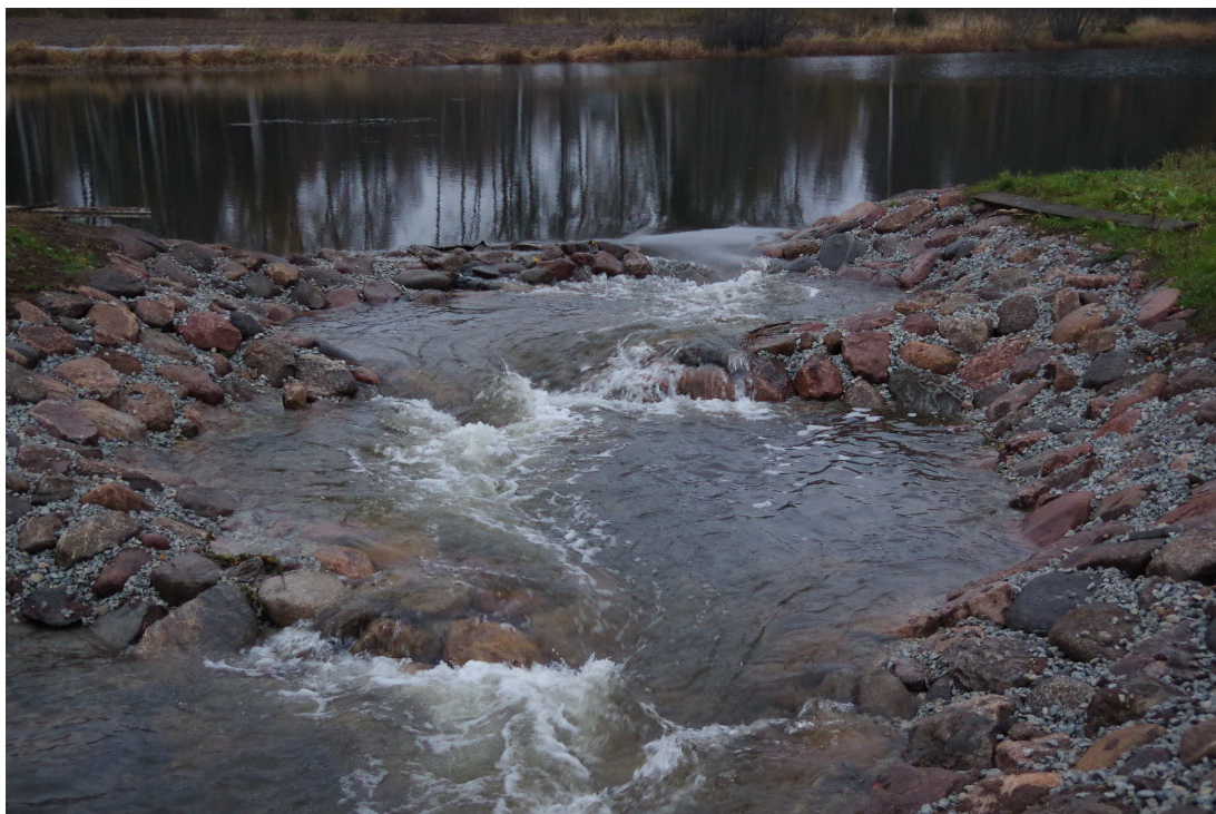
Foto 5. Ülesvoolu vaade kalapääsu väljapääsule (sissevool) ja paisjärvele. Sissevooluava võiks olla mõnevõrra laiem ja (pildil) vasakult laugemalt tõusva künnisega nagu seda on teised ülevooluläved. (25.10.15)
