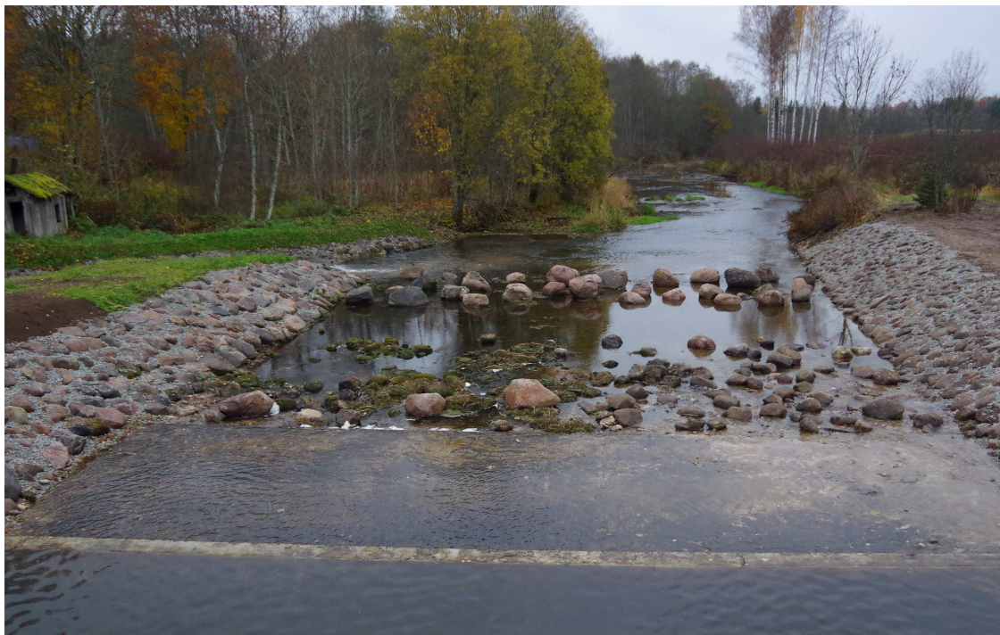
Foto 2. Vaade liigveelaset ületavalt sillalt allavoolu. Vahetult enne vasakult suubuvat kalapääsu on sängiga risti asetsev kivirida, mis peaks suunama vee liigveelaskmelt kalapääsu suudme juurde. Esiplaanil voolurahustuskaevu betoonserv. (25.10.15)
