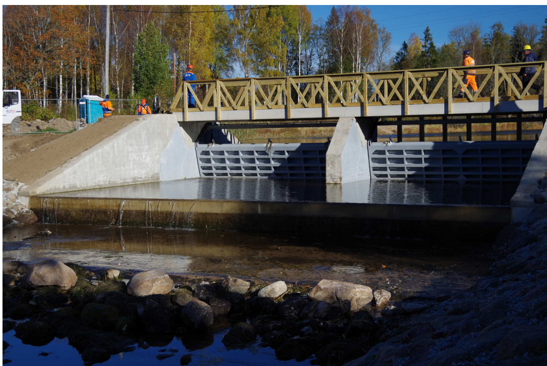
Foto 6. Vaade liigveelasule ja selle all olevale voolurahustuskaevule. Väikeste vooluhulkade perioodiks tuleks rajada väljapääs kaevust pildil paremasse serva (vasaku kalda äärde) ühes renniga üle selle aluse betoonpõranda, koondades õhukese kogu ülevoolufrondi laiuses niriseva vee üheks kitsamaks ent tusedamaks kihiks, mis võimaldab kaladel kaevust lahkuda. (15.10.15)
