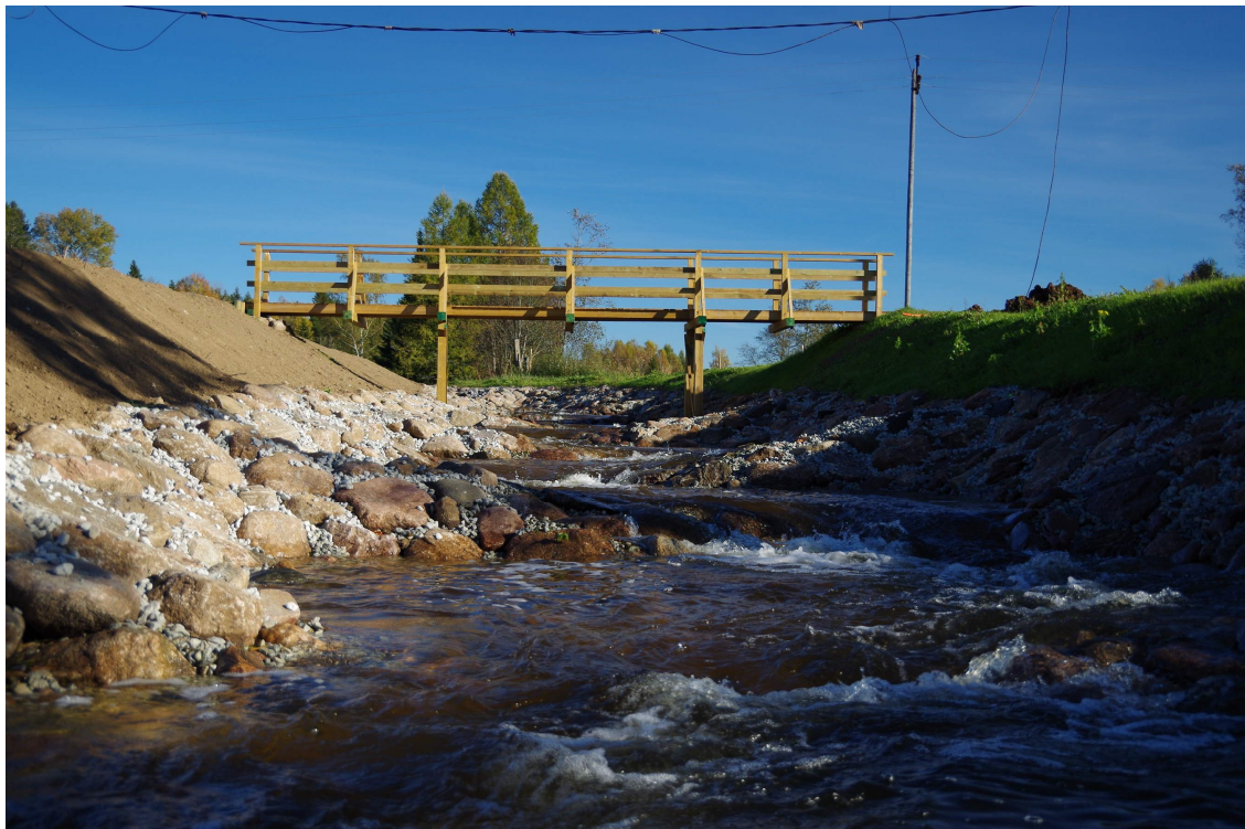
Foto 4. Vaade pääsu põhiosale ülesvoolu. Esiplaanil alt lugedes 4. ja 5. aste enne 4. astme korrigeerimist. Veetasemete languse erinevus on visuaalselt hästi märgatav. (15.10.15)
