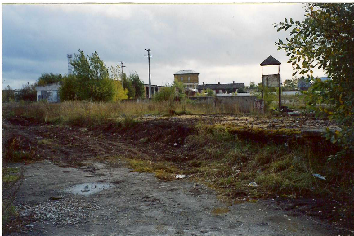
Foto 4 Estakaadi maapealne osa lammutati, betoonmahuti tühjendati õldest ja täideti liivaga ning ümbritsev reostatud pinnas kompostiti. Fotograaf N. Reinap 28.09.2001.a.
