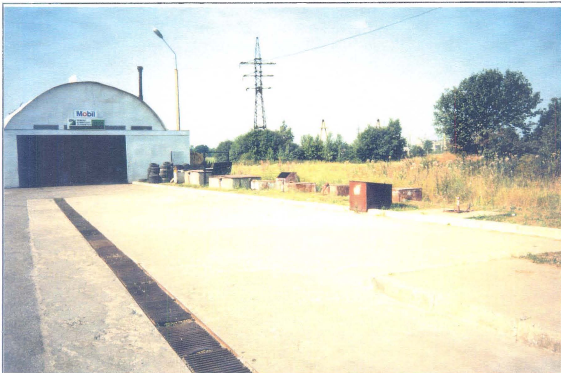
Foto 2-1 As NIVALS tankla. Vaade maa-alusele mahutipargile. Vasakul metall-restidega kaetud sadevee kogumise renn
