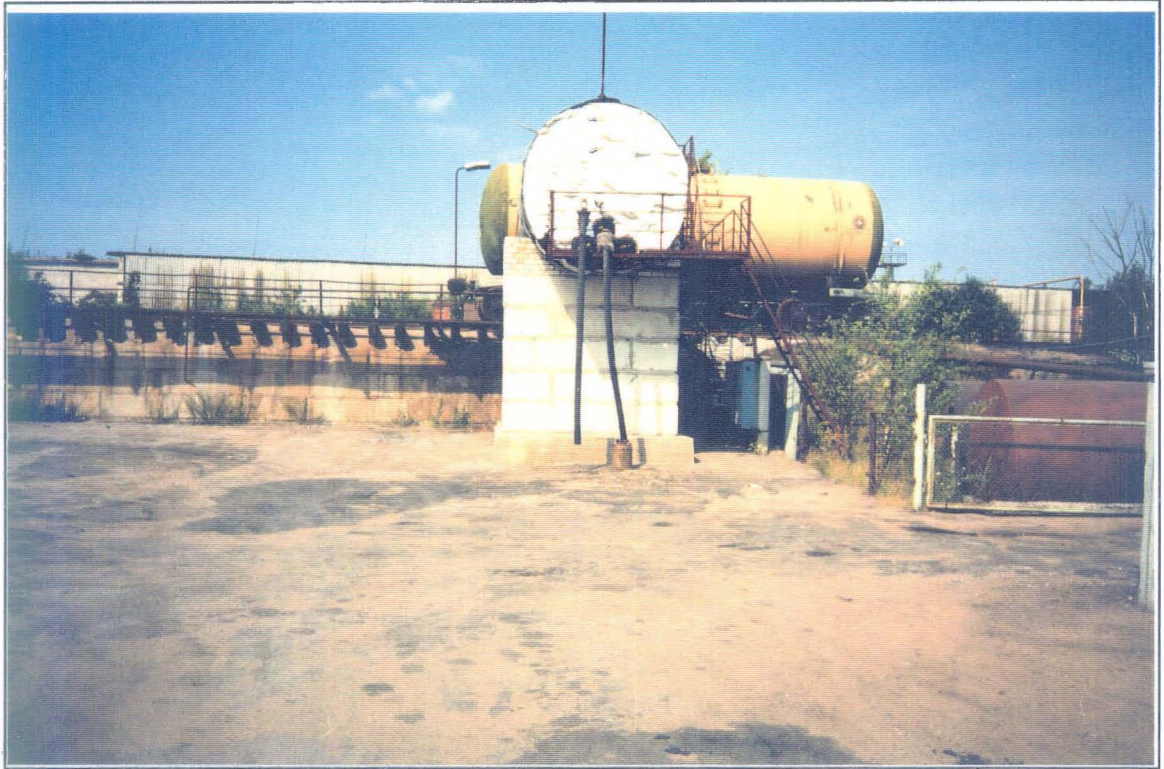
Foto 4-1 Lääne-Viru raudtee-äärne bituumeni ja õlide vastuvõtusõlme laadimisplats. Tagaplaanil on raudtee-estakaad, mille ees kivipostidel 50 m 3 õlimahuti.
