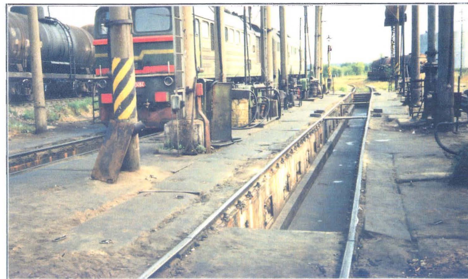
Foto 8-4 Tapa Veduridepoo kütusetankla. Näha betoonplaadid ja -süvend.
