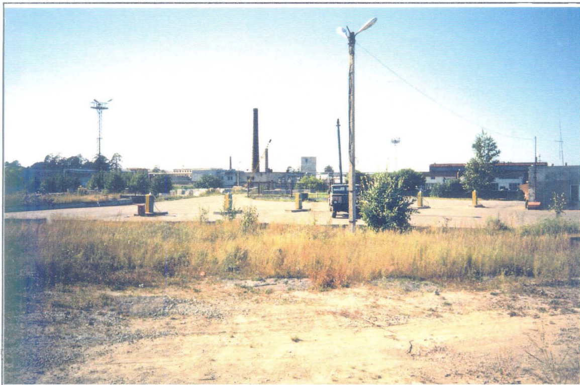
Foto 5-2 Oü Rakvere Autobaasi tankla. Vaade tankimisplatsile. Taamal kütusehoidla.
