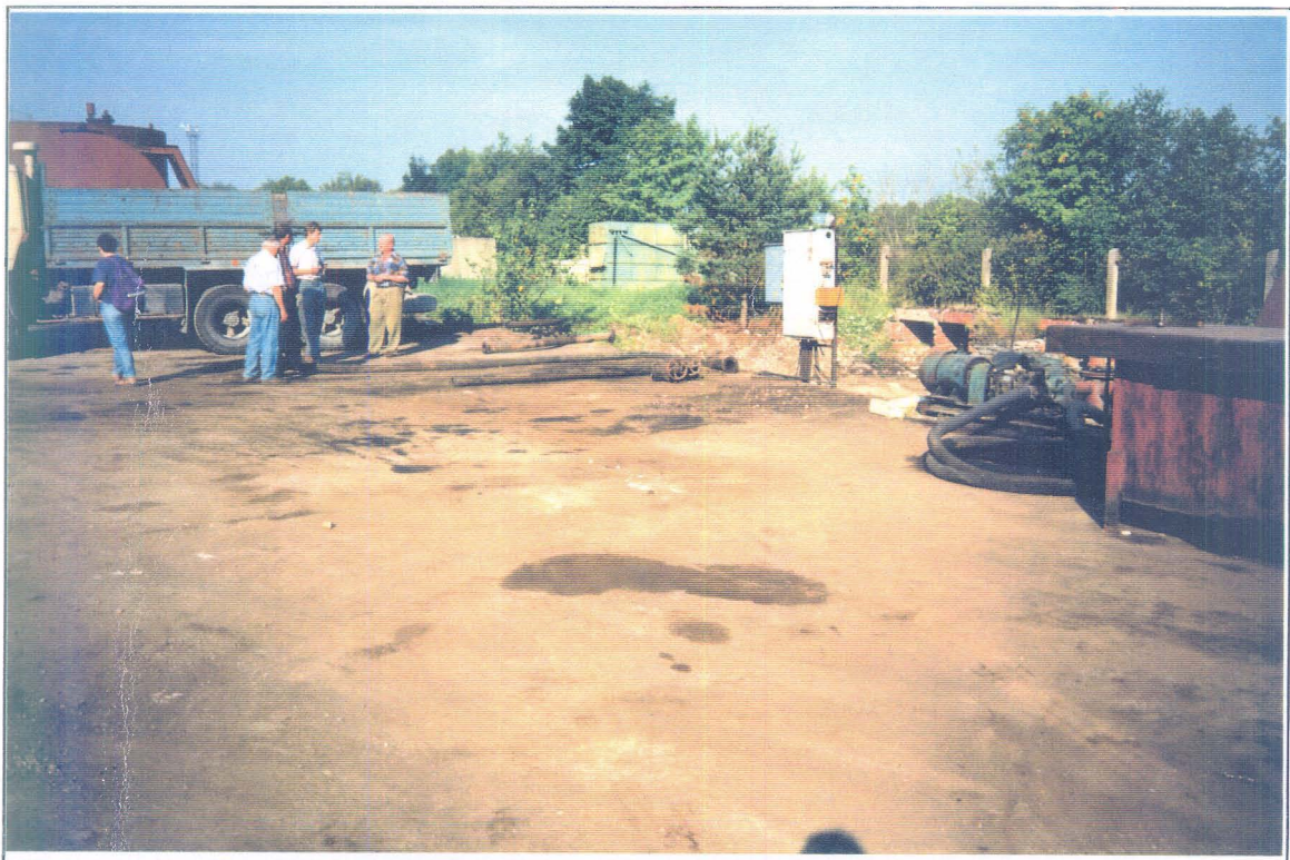
Foto 1-3 Demonteeritud õlimahutite esine asfaltplats, kus on märgata õlilaike.
