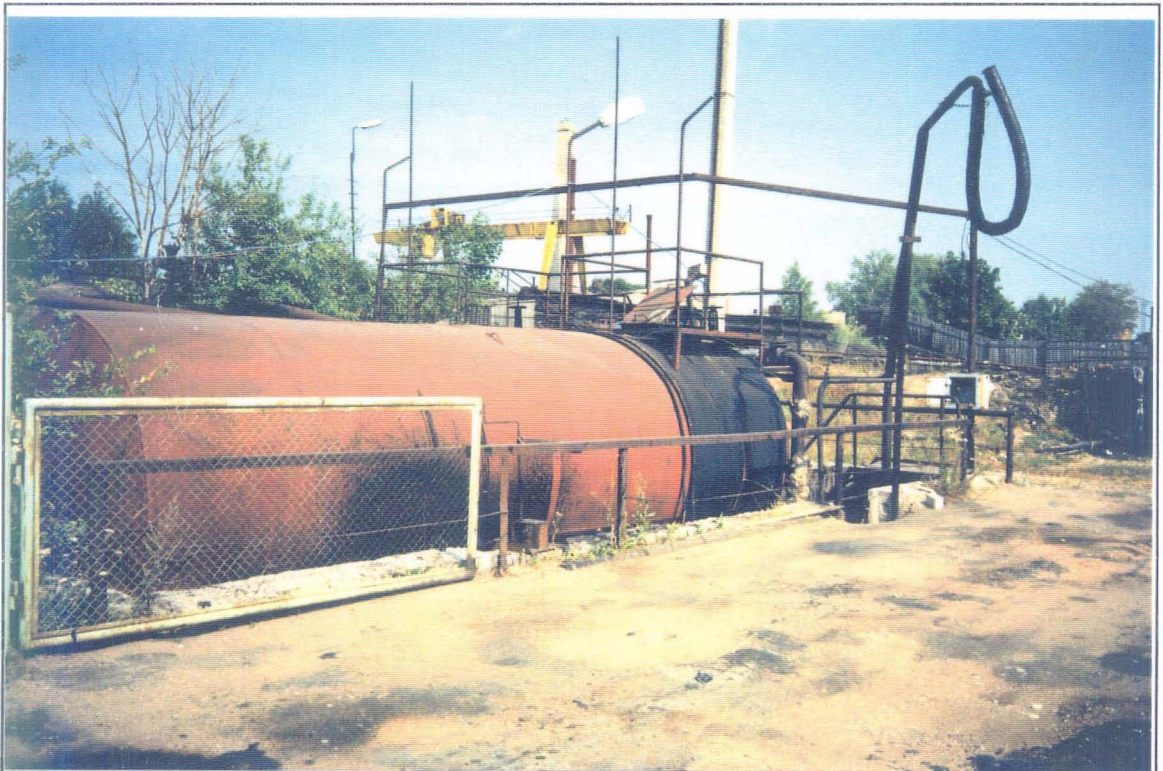
Foto 4-2 Betoonseinte ja -põhjaga süvendis lamav 25 m 3 tsistern koos selle otsas olevate pumpamiseseadmetega. Paremäl näha fragmēt bituumenibasseinist.
