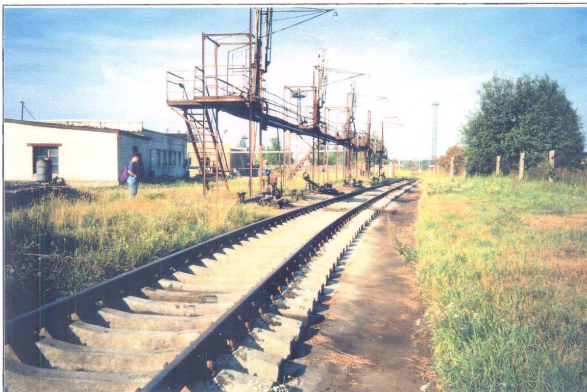
Foto 1-1 Rakvere Naftaterminaali kütuse raudtee-vastuvõtusõlm ja estakaad. Vasakul pumbamaja.
