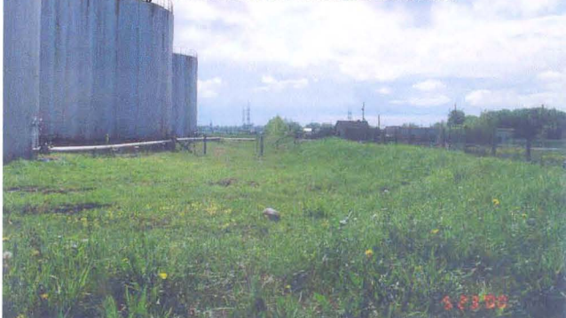
Foto 39. Vaade mahutipargile, mille ümber puuduvad vee ja naftasaaduste kindlad katendid
