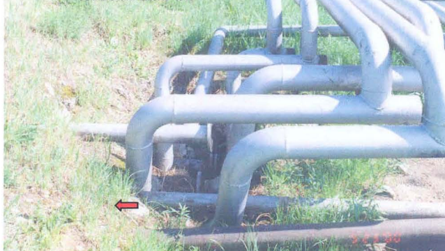
Foto 37. Mahutipark. Mahuti nr. 31 torud. Terminaali torustike remonttöödel torustikes olevad naftasaadused on valgunud pinnasesse.
