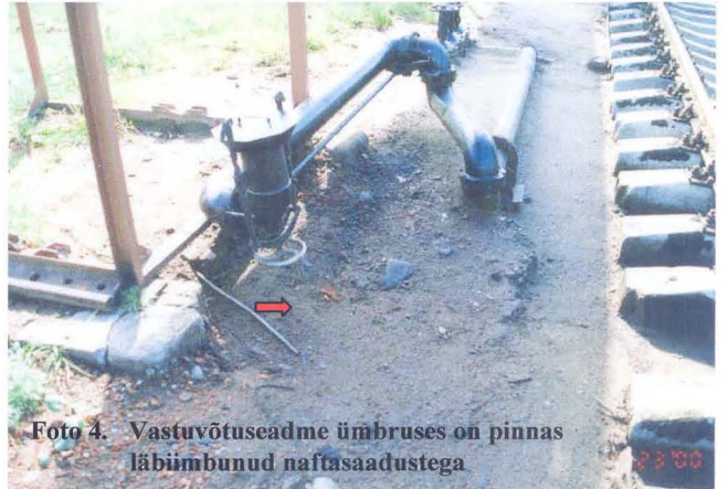
Foto 3. Naftasaaduste laadimisestakaadi vastuvõtuseade
