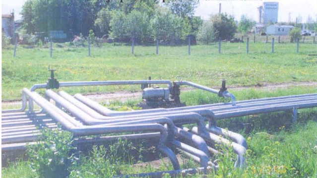
Foto 34. Torustik tsisternautode laadimisplatsi kõrval. Siibrite ja pumbal puudub avariivann.
