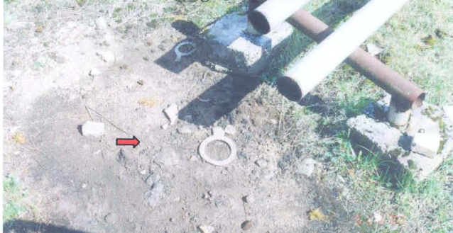
Foto 37. Mahutipark. Mahuti nr. 31 torud. Terminaali torustike remonttöödel torustikes olevad naftasaadused on valgunud pinnasesse.
