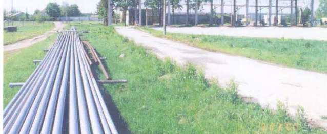
Foto 35. Tsisternautode estakaadini suundub naftasaaduste torustik maa-alt
