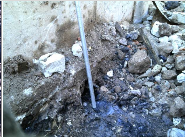
Foto 4.2. Lahtikaevatud endise kütusehoidla vundamendi alt välja juuva drenaažitoru otsa olise settega
