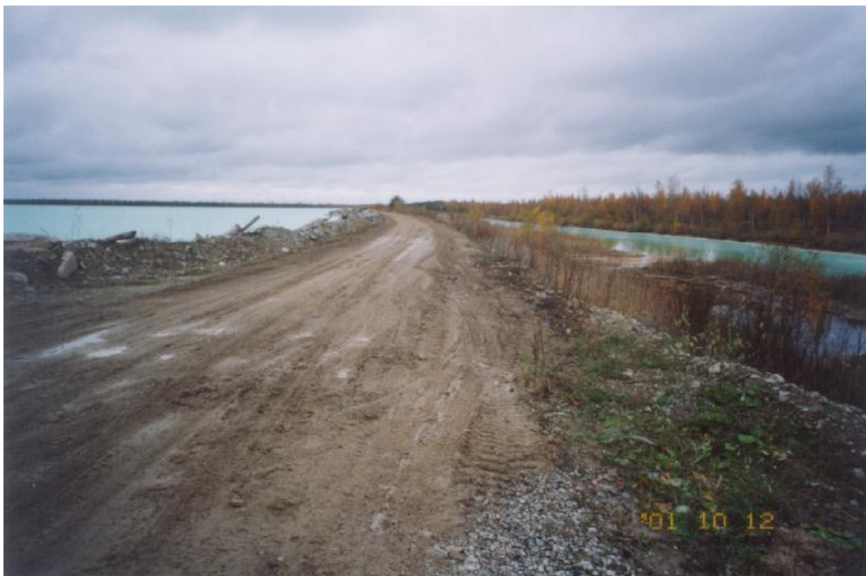
Foto 5- Settetiigi jäpurrust idatamm. Paremalt on selitatud vee tagasivoolukanal nr 2. Vasakule settetiiki ehitatakse olevast tammist 2,5 m võrra kõrgem piirdetamm. Vaade põhja
