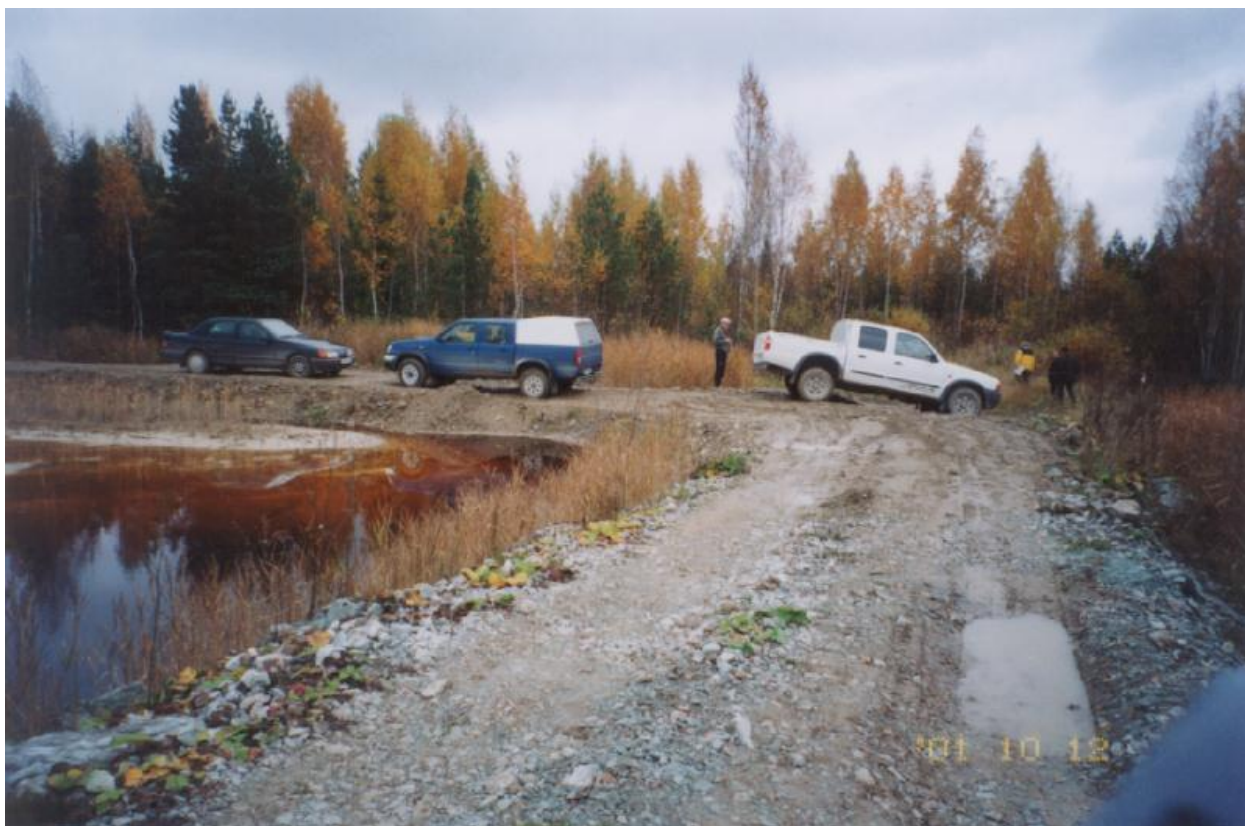
Foto 6- Idatammi otsas settetiigi kirdesopis on vesi pruuni värvusega Kõrgesoost valguva huminainete rikkast pinnaseveest. Idatammist vasakule rajatakse uus piirdetamm. Paremale kaevatakse drenaažikraav tagasivoolukanalini nr 2, lõunasse. Sellel 400 m pikkusel lõigul filtratsioonitõkke ekraani ei rajata. Vaade põhja.
