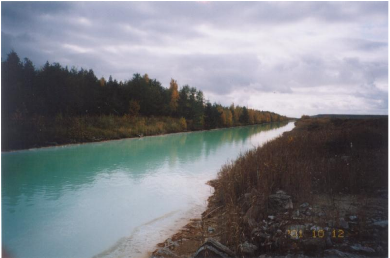
Foto 7- Settiigis selitatud vee tagasivoolukanal nr 2. Vasakule kalda tammi rajatakse filtratsioonitõkke ekraan settetiigi veelaskudest nr 7 ja 8 kuni ühtlustustiigi lõunakaldani, 5.7 km pikkuselt. Vaade allavoolu lõunasse.
