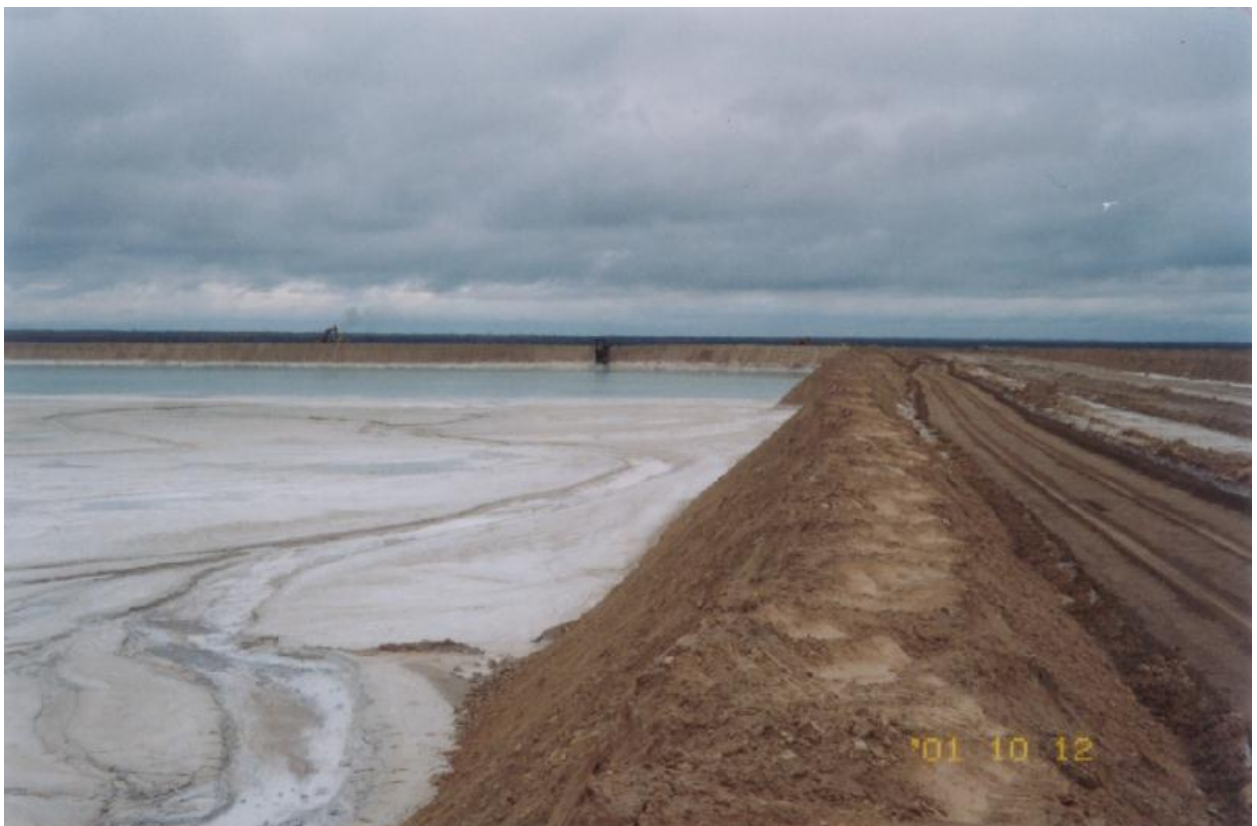
Foto 2- Tuhavälja 1. sektsiooni tamm ja põhjalask nr 2 (taamal) selitatud pulbivee juhtimiseks settetiiki järelselituseks. Vahetammist vasakul on valkjas tuhasete
