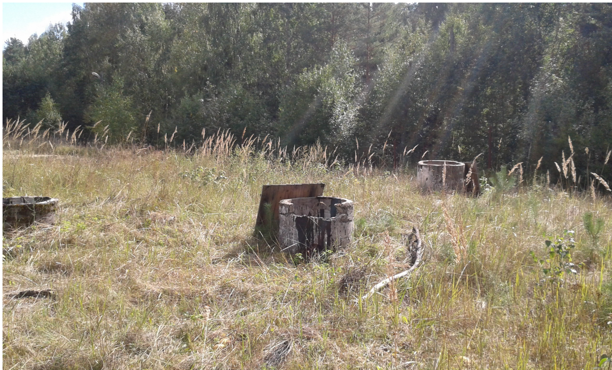
Foto 1. Maa-aluse mahuti kontrollkaevud
