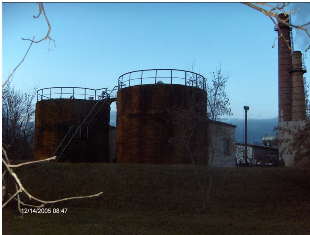
Photo 5000 Tanks of Põlva Masuudihoidla
