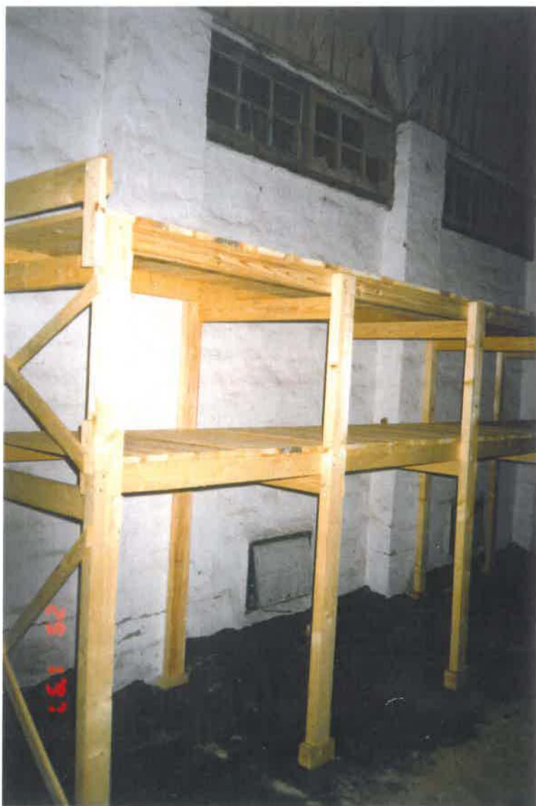
FOTO 2. Maramaa ohtlike jäätmete (ajutises) hoidlas on puidust riulid ja põrandast 20 cm kõrgusel ventilatsiooni luugid
