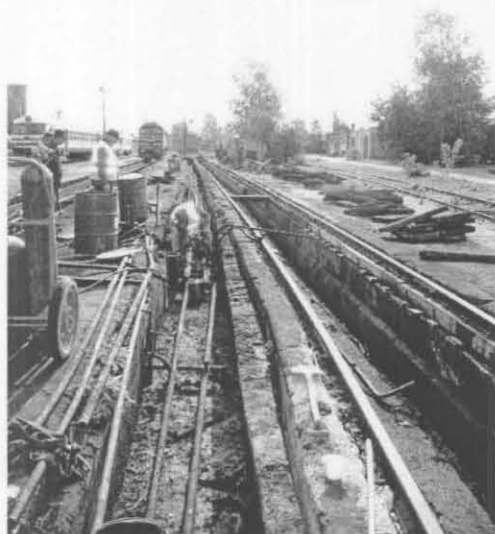
Foto 5. Torustikekanali torude demonteerimine
