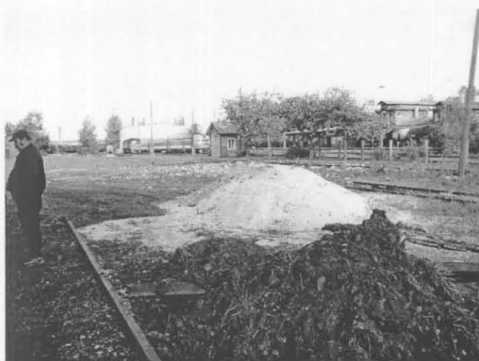
väljatõstetud pinnas, segatuna saepuruga
