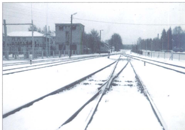
Foto 44. Türi jaam. Vaade jaama territooriumi kõrval paiknevale trafoalajaamale
