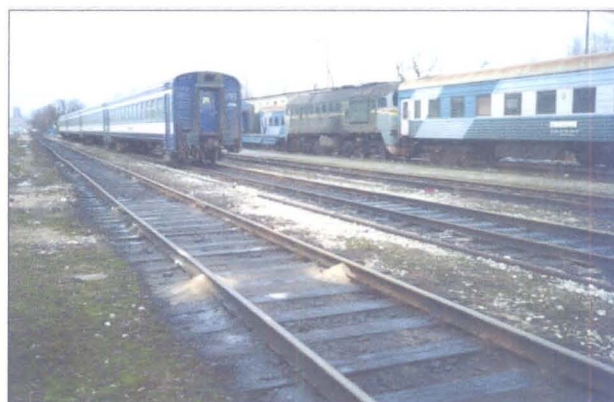
Foto 18. Tallinn-Väike jaam. Naftasaadustega reostunud rööbastee ja reisivagunite seisuplats.
