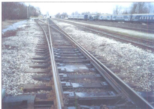
Foto 22. Tallinn-Väike jaam. Õline pöörang ja reisivagunitest helibarjäär.
