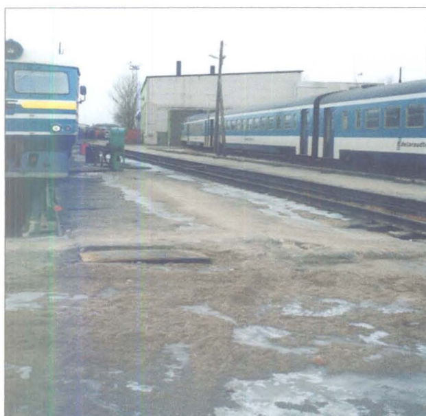
Foto 25. Tartu depoo. Vaade diieslongide vaatluskanalitele. Kanalite vahel diieslütuse tankimisautomaat
