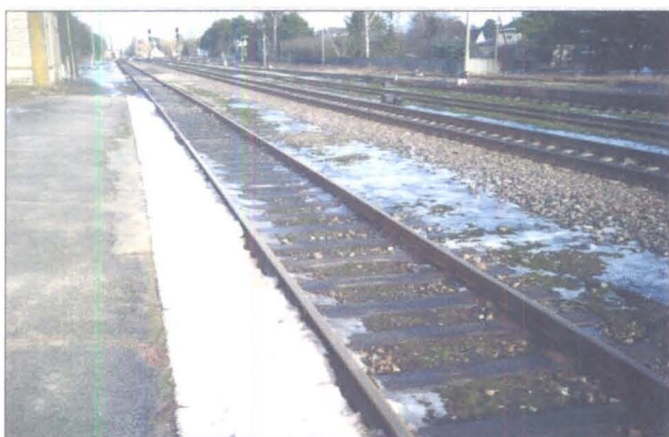
Foto 17. Liiva jaam. Naftasaadustega reostunud rööbastee.
