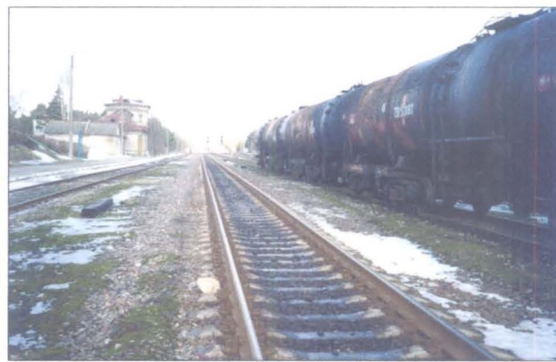
Foto 16. Liiva jaam. Naftasaadustega reostunud rööbastee.
