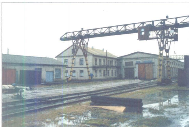
Foto 31. Mõisaküla depoo. Vaade depoo kontorile ja vagunite remonditsehhile. Vasakul pool garaažihoone
