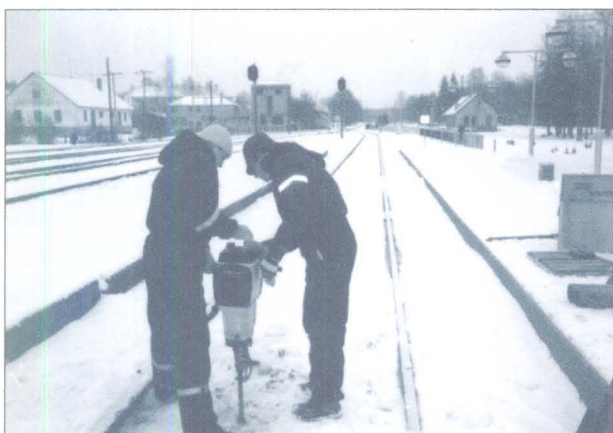
Foto 45. Türi jaam. Puurimine ja pinnaseproovide võtmine diiselrongide seisukohas
