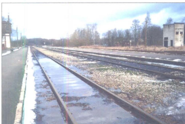
Foto 9. Rapla jaam. Vaade põhja suunas. Rööbastee naftasaadustest kohati reostunud.
