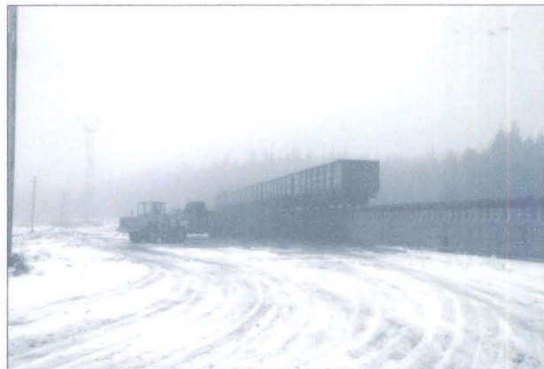
Foto 36. Pärnu jaam. Puistematerjalide estakaad. Estakaadi ümbritsev laadimisplats asfalteeritud
