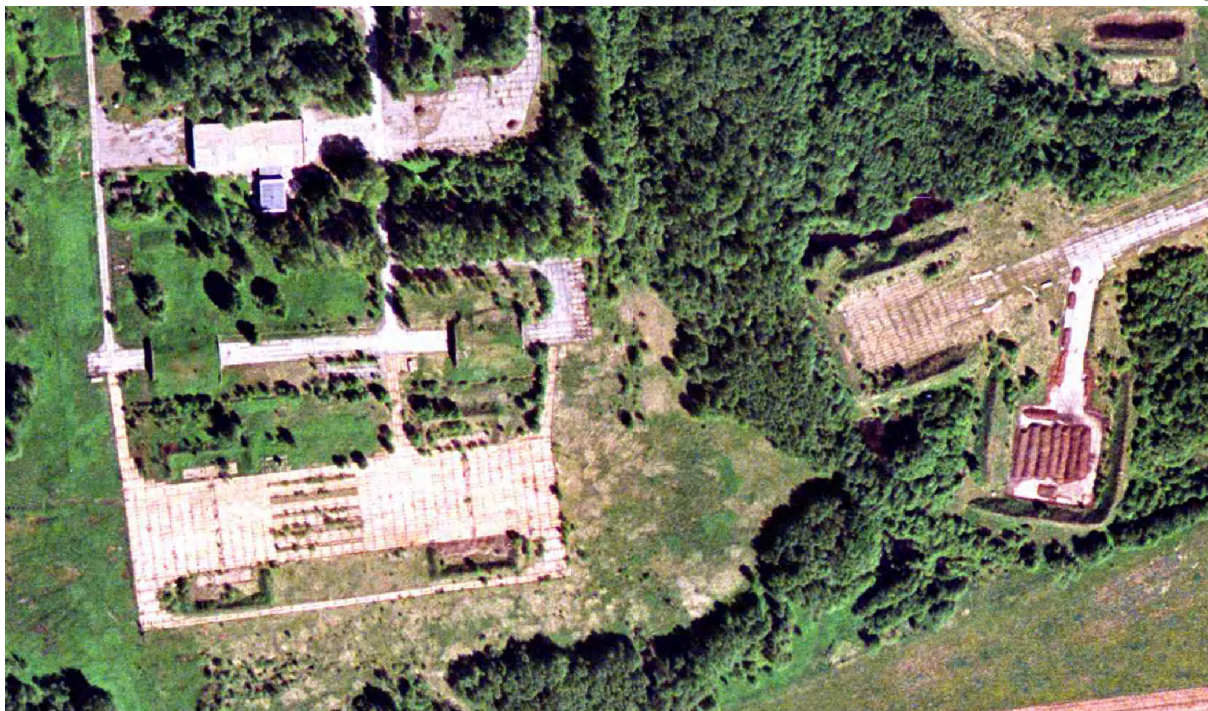
Foto 4 Aerofoto Raadi lennuvälja raketibaasist eelmise sajandi üheksakümnnendate lõpust, samiiniga reostunud pinnas on välja kaevatud ja komposteeritud idas oleval lennukite parkimisplatsil
