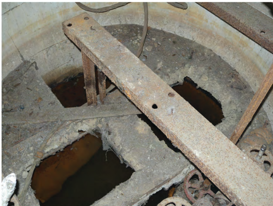
Foto 16 Puiduimmutustehase töötamise aegne дренаáživee jaotussõlm.JPG
