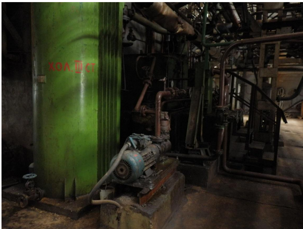
Foto 1 Kompressori alune seadmestik. Betoonpõrandal on näha õilekete jäljed.
