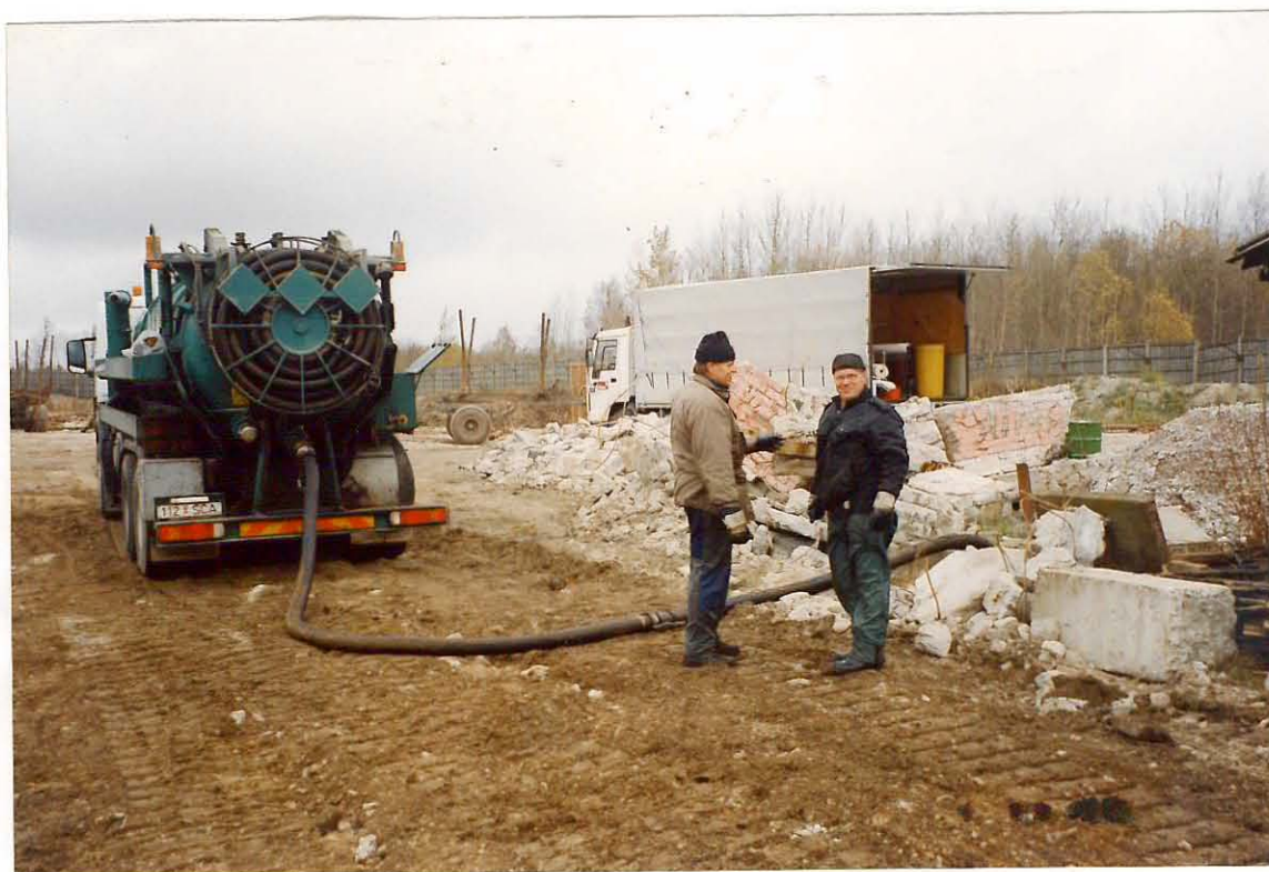
Foto 4 Kaadmiumiga reostatud endise galvaanikatsehhi kanalisatsioonisüsteem puhastati paakautoga. N. Reinap 11.09.99.a.
