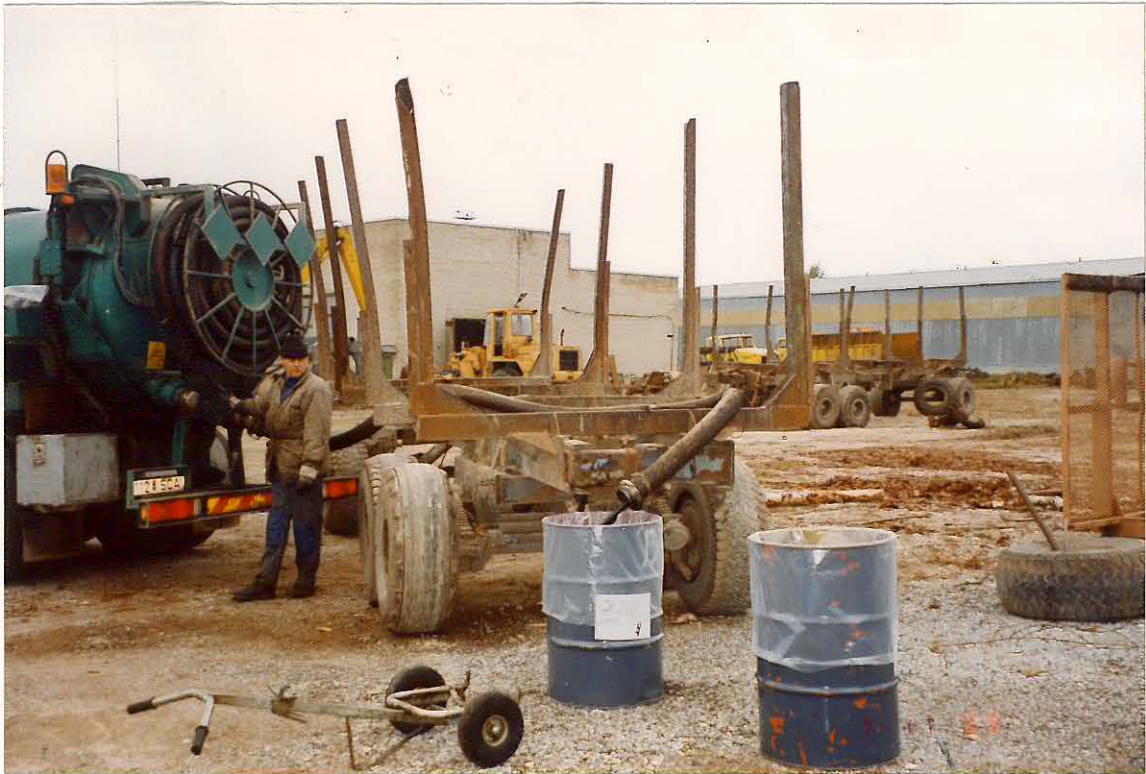
Foto 5 Kaadmiumiga reostatud kanalisatsioonised pumbati kilekottidega vooderdatud vaadidesse. Fotograaf N. Reinap 21.07.99.a.
