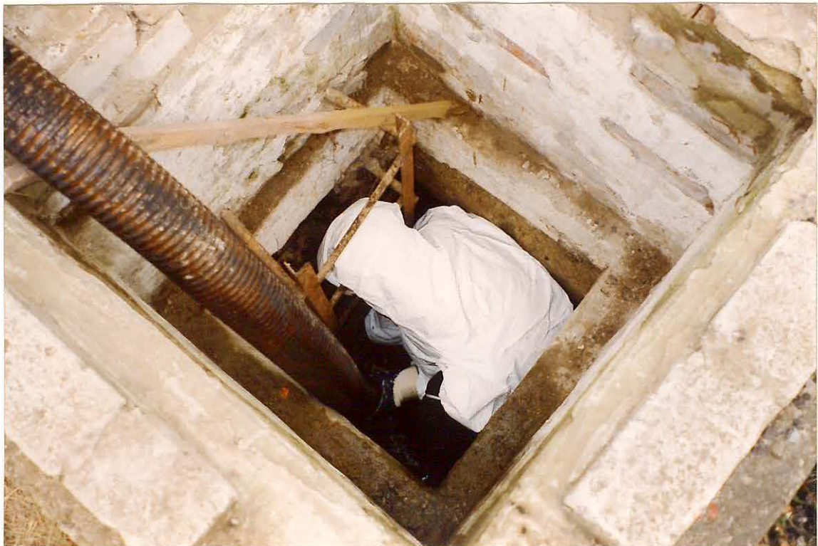
Foto 6 Mahajäetud puhastusjaama settemahutite puhastamine kaadmiumijäätmetest. N. Reinap 11.09.99.a.
