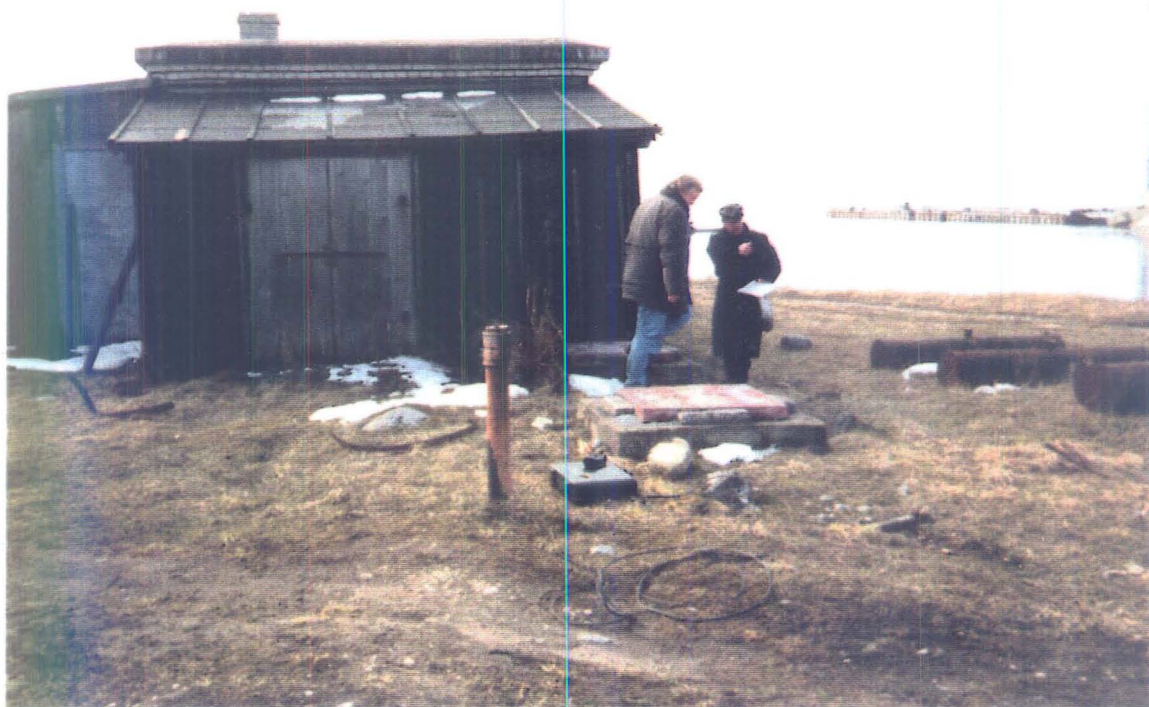
Foto 8. AS Larga territoorium. Näha kanalisatsioonikaev, kus on naftakihiga kaetud vesi. Kaevus olev sete reostatud kaadmiumiga.
