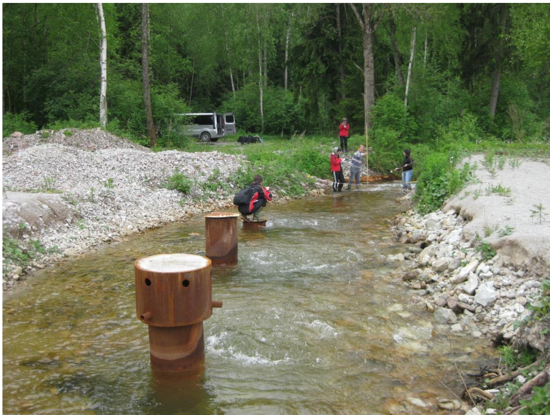
Joonis 42 Projektipõhiselt korrastatud kaevandusvee väljaool Ahtme kaevandusest
