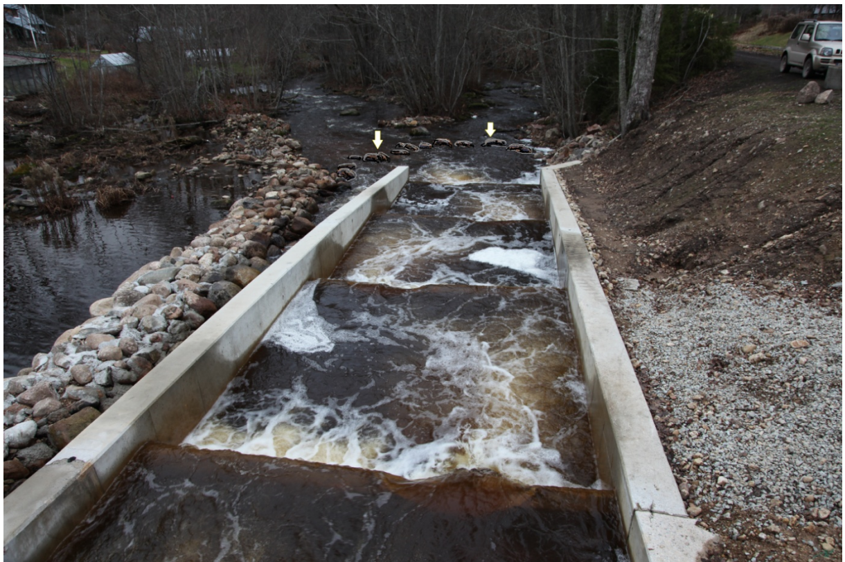
Foto 2. Kalapääsu alla on vajalik vee äravoolu paisutamiseks rajada suurtest kividest tõkend kärestik mis tõstab veetaset 15-20 sm, (vt. nooltega näidatud piirkonnas ).
