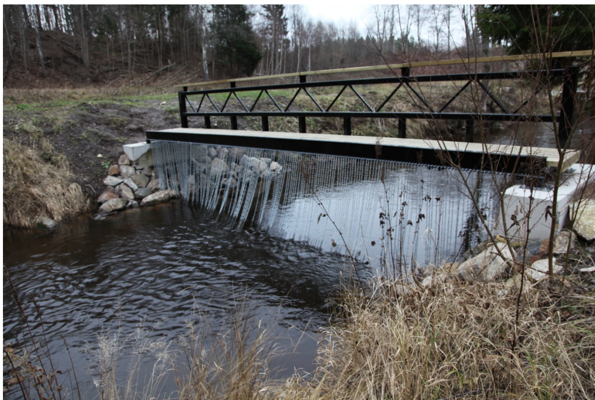
Foto 3. Elektriijaama väljavoolu kanalissee kalade siirdumise tõkestamiseks rajatud kett-kardin.
