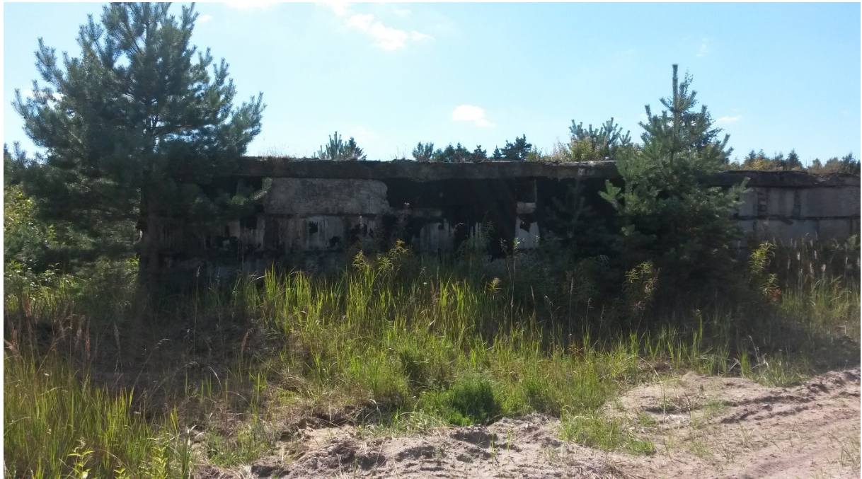
Foto 2. Endine pumplahoone. Mõõtmed ca 13,2x13,2 m. Betoonplokkidest, sees telliskivist abiseinad ja metallist pumpade alusraam.
