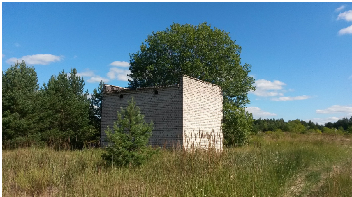
Foto 1. Endine alajaama hoone. Telliskivihoone betoonplokkidest vundamendil. Mõõtmed ca 5,25x6,3 m. Kõrgus parapetipoolsel seinal ca 4,7 m.
