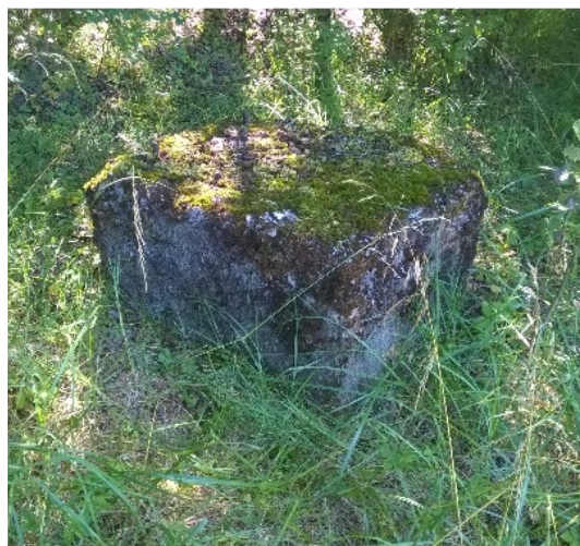
Foto 10. Mahutite alused vundamendid. (19.08.2015, Maves AS)
