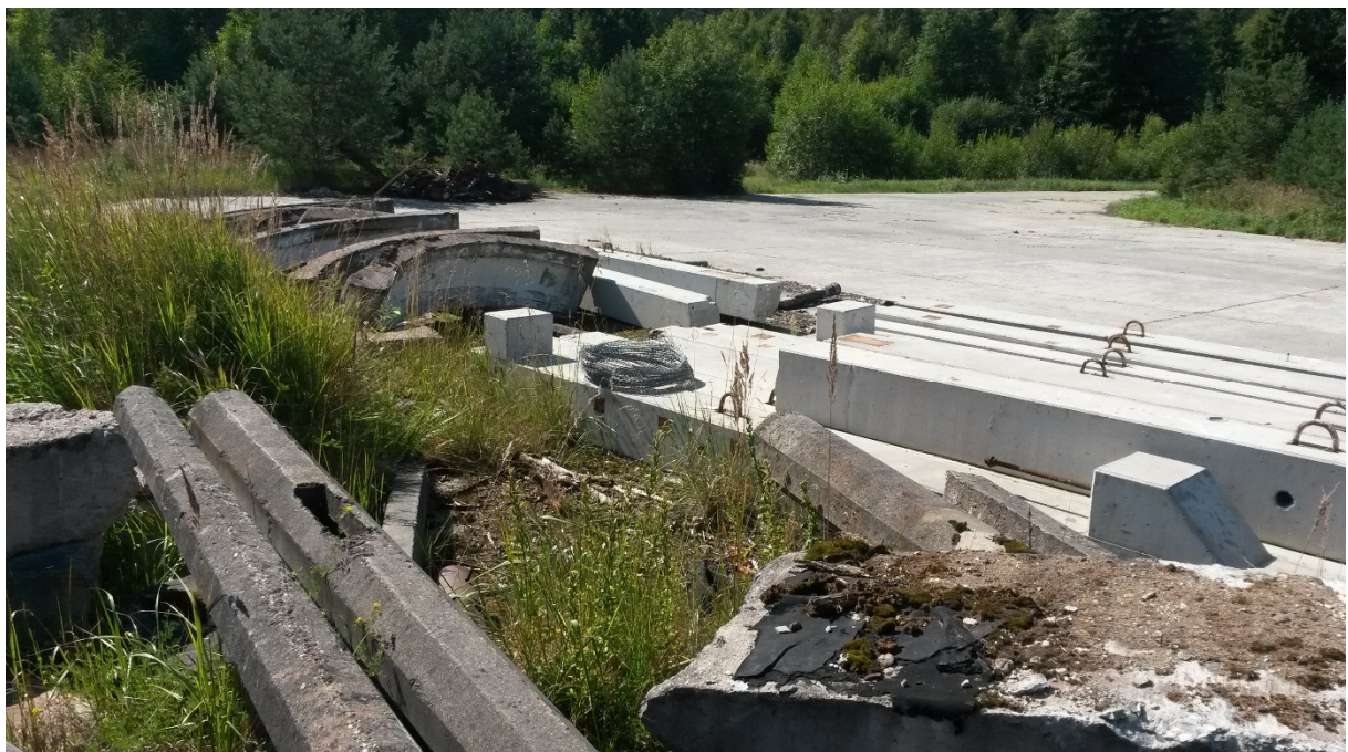
Foto 3. Likvideerimisele kuuluv betoonplats koos sellele ladustatud betoonelementidega.
