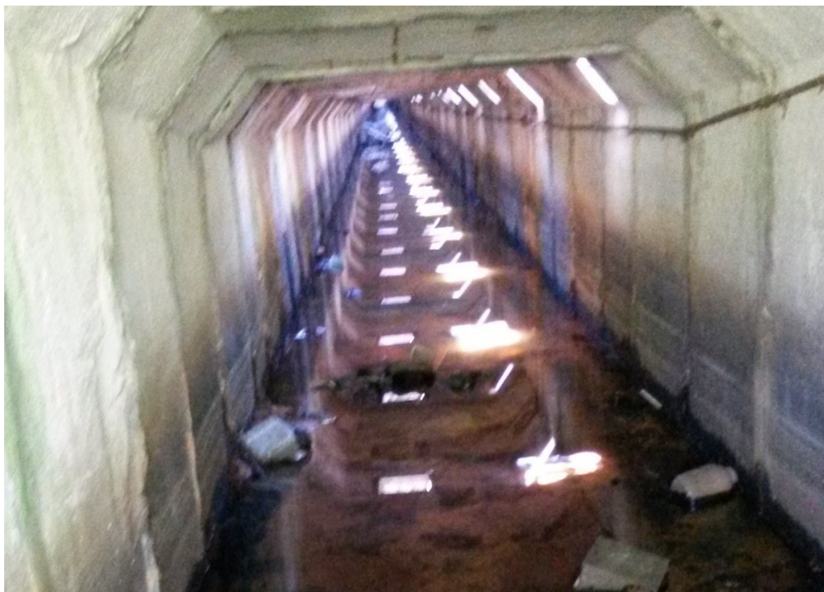
Foto 8. Betoonelementidest transportöörkanali seestvaade.
