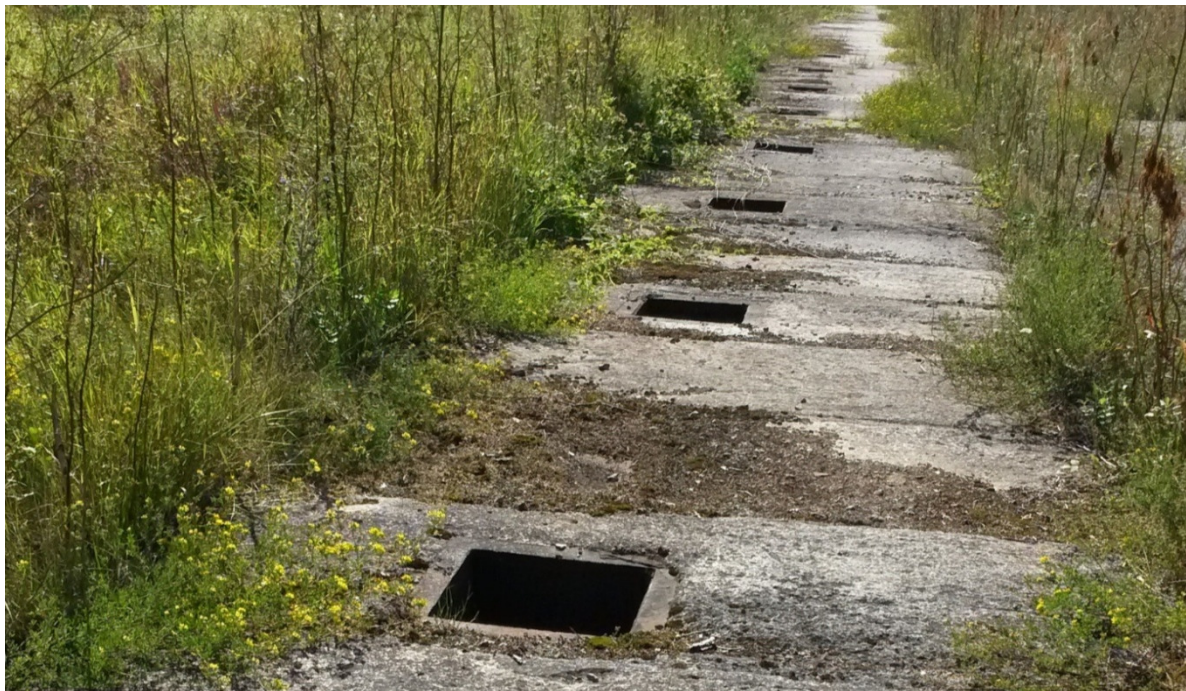
Foto 7. Betoelementidest transportöörkanali pealtvaade.
