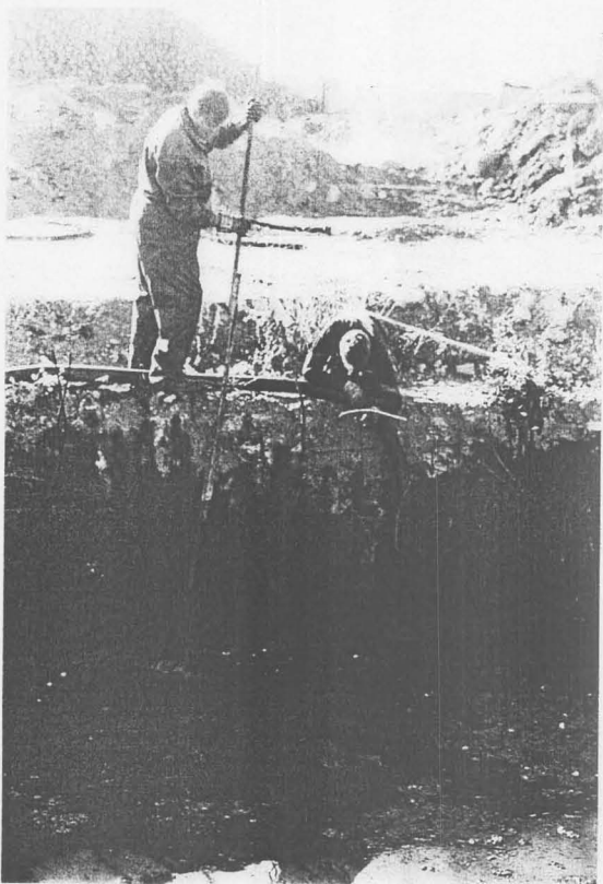
Foto 53. Vabadi ja sorbendi eemaldamine endisest õlipüüdist (03.09.99).
