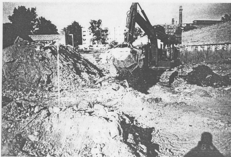
Foto 18. Kaevetööd 600 mm diameetriga kollektori vahetusläheduses.
