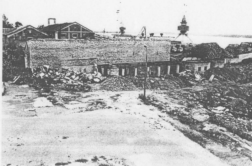
Foto 26. Puhas pinnas teisaldati reservi. Fotol on selekteeritud puhta vanametalli, raudbetoonlahmakate ja kooritud pinnase hunnikud.
