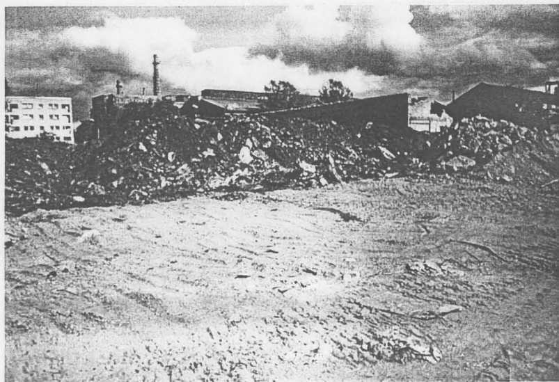
Foto 14. Nõrutusplatsi põhja veeti renoveerimistööde käigus liiva, et mitte vigastada nõrutusplatsi põhja juba 1998. a. rajatud drenaažisüsteemi.
