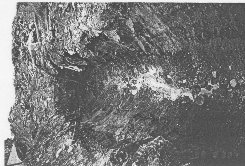
Foto 40. Tranšeed nr. 1 pumbati korduvalt kuivaks. Ehe õli veepinnalt pumbati GAZ-53 olevasse autopaaki ja teisaldati endisesse õlipüüdjasse. Vesi tranšeest nr. 1 pumbati tranšeesse nr.2.
