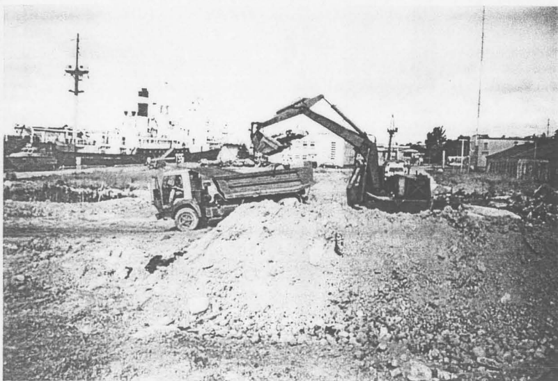
Foto 10. 1999. a. nõrutusplatsi renoveerimine ja laiendamine.
