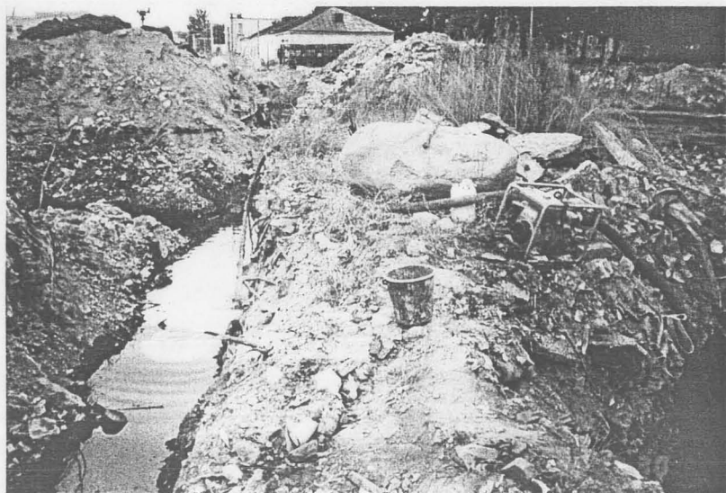
Foto 42. Õliseguse vee pumpamine tranšeest nr. 1 tranšeesse nr. 2.
