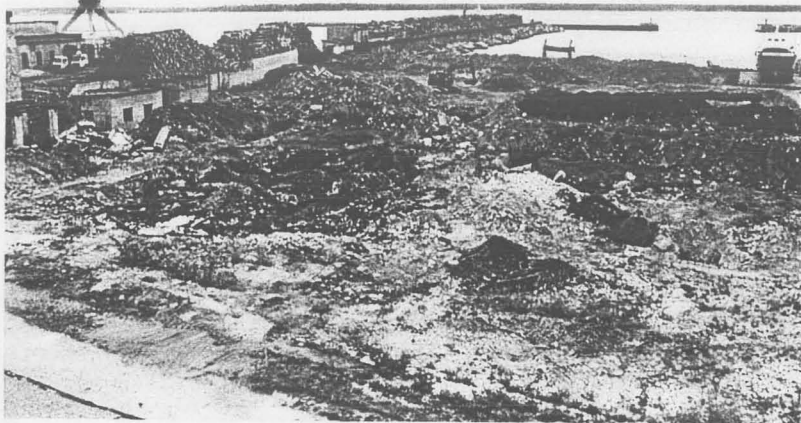
Foto 25. Puhastatava territooriumi kirdeosas on pinnas 40 cm sügavuselt ja 15 cm paksuselt läbiimbunud viskoosse määrdiõliga. Liivsavis pole reostus levinud.
