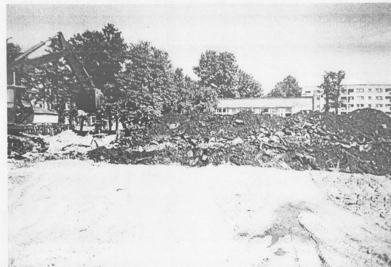
Foto 31. Teisaldatud reostunud pinnas nõutusplatsil. Nõutusplatsil selekteeriti erineva reostusastmega pinnas. Nõutusplatsi laiendati reostunud pinnase teisaldamise käigus.
