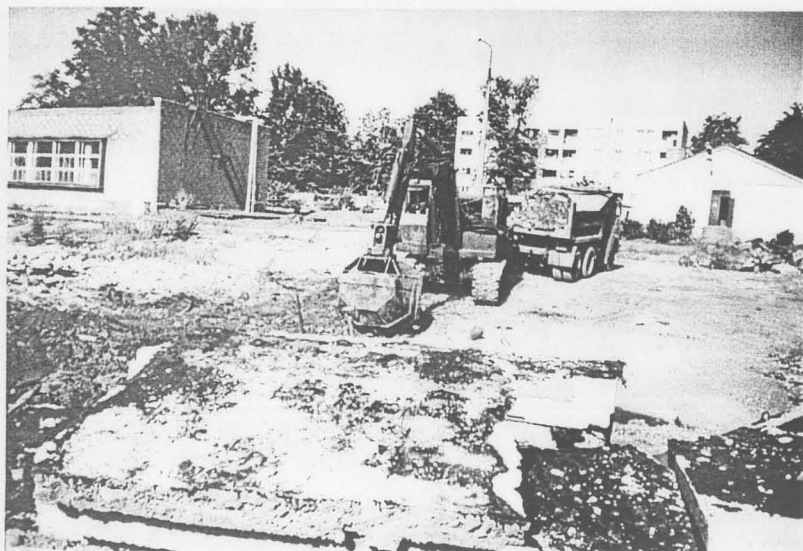
Foto 22. Puhastatava endise kütusehoidla territooriumilt puhta pinnase koorimine ja teisaldamine reservi.
