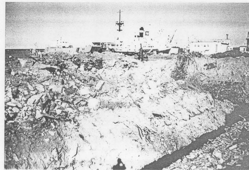
Foto 4. Endise kütusehoidla territooriumil tuli kaevetööde käigus sorteerida ja ladustada vanametalli, mis segasid edaspidiseid puhastustöid.
