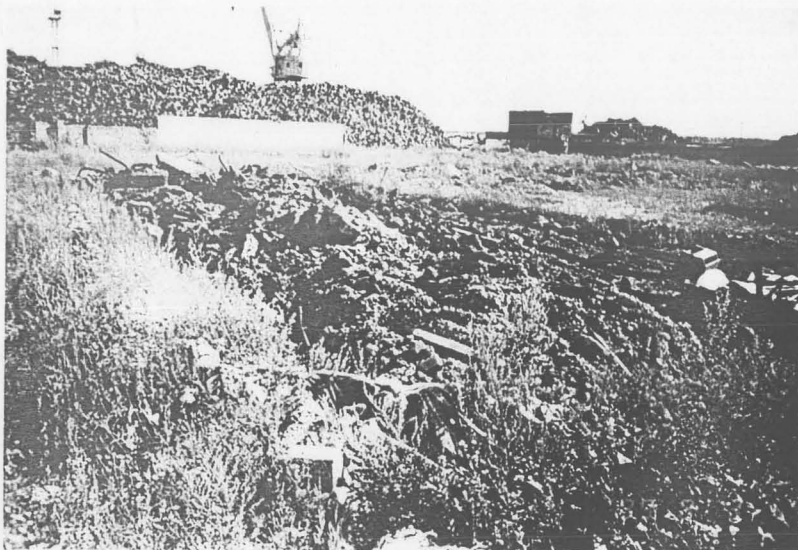
Foto 9. 1998. a. rajatud nõrutusplats, millel 1 m paksune ülemine kiht oli puhas. Nõrutusplatsi tagaosas olevad raudbetoonkamakad ja vanaraud on sademete toimeel puhastunud. Sadevesi infiltreerus nõrutusplatsi drenaaži mööda õlikogumisbasseini.
