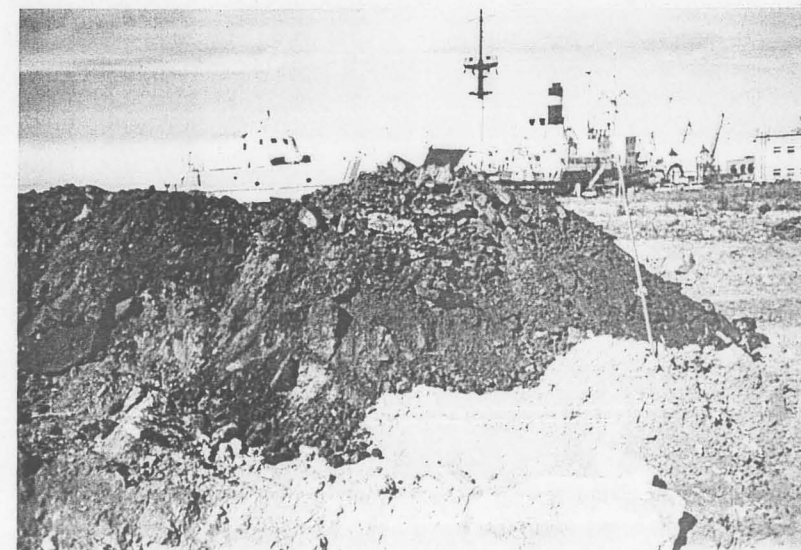
Foto 28. Tranšeedest teisaldatud täitepinnas on ebaühtlaselt reostunud. Täitepinnas on segunenud paelahmakatega. Naftasaadustega reostunud paelahmakad veeti nõrutusplatsile.
