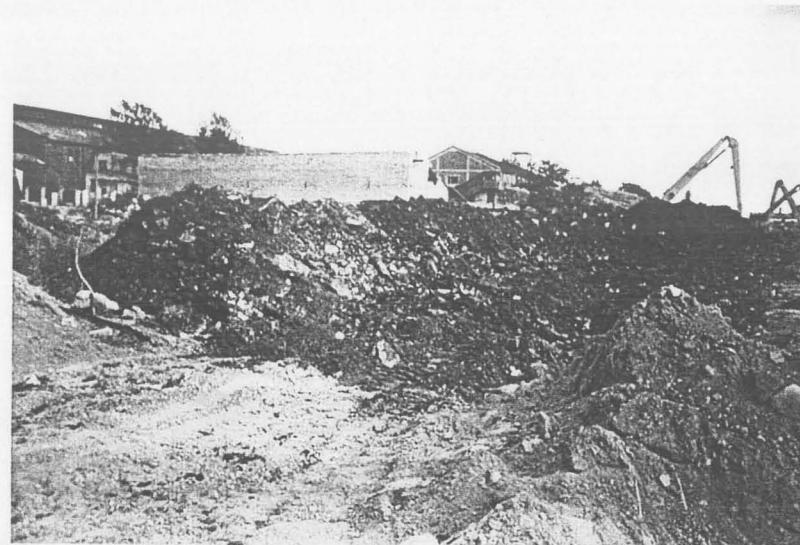
Foto 11. Nõrutusplatsi tahaossa veeti esmalt enam reostunud pinnas, samaaegselt nõrutusplatsi tamme kasvatades.
