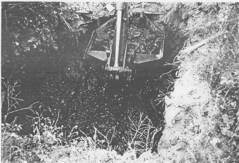
Foto 29. Süsta tn. 15 endise kütusoidla kesk- ja lõunaosa täitepinnas alates 2 m sügavuselt on tugevalt reostatud naftasaadustega. Põhjavee ülemisel kihil lasub vabaõli.
