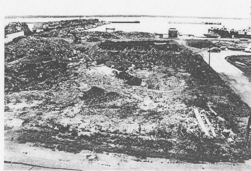
Foto 24. Puhastatava territooriumi põhjaosas pole pinnas ja põhjavesi reostunud naftasaadustega (põhjavee peal pole vabaõlikihti).
