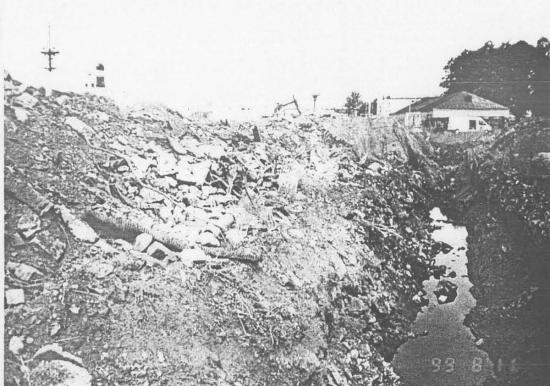
Foto 33. Tranšee nr. 2. Seisuga 11.08.99 on tranšee täitunud veega, veepinnal on õlikirme.
