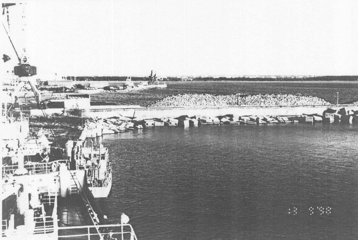
Foto 16. Vaade Bekkeri sadama kaile, kuhu suubub endisest kütusehoidla puhastusseadmest algav kanalisatsioonitrass. Momendil olevat antud kanalisatsioonitrass suletud, kuid mis vajaks likvideerimist.
