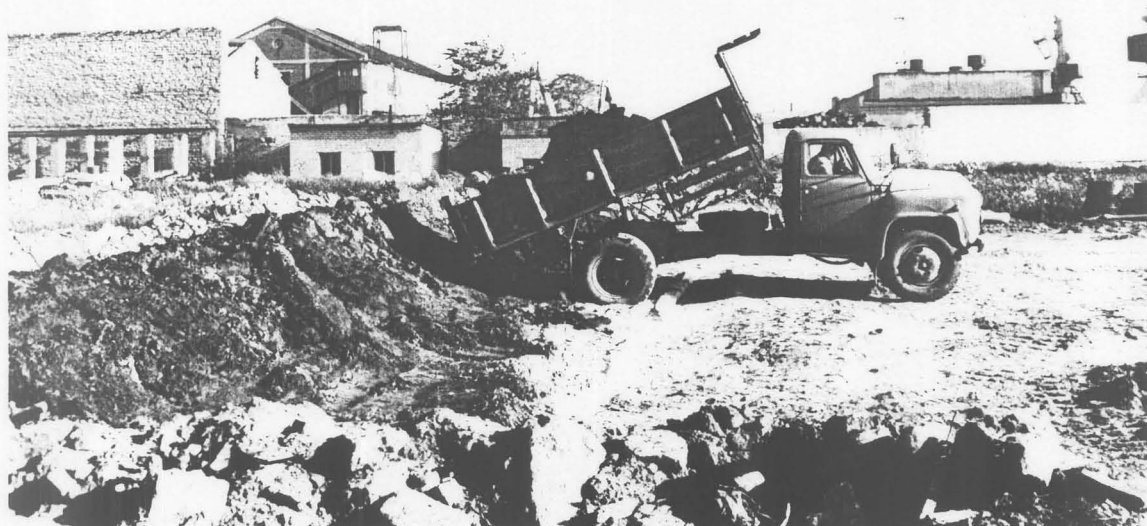
Foto 23. Reostunud pinnase teisaldamine nõrutusplatsile.
