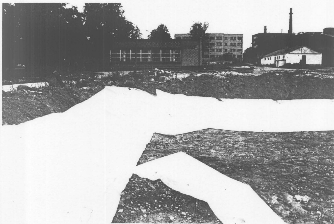
Foto 18. Nõutusplats isoleeriti ümbritsevast pinnasest polüetüleenkilega, mille peale pandi melioratiivriie, et vältida polüetüleenkile purunemist.
