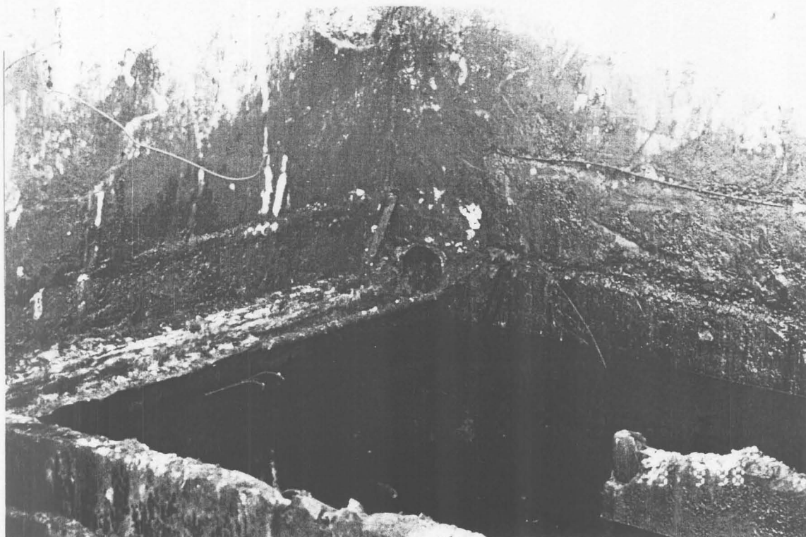
Foto 15. Vaade avale, mis on ühenduses praeguseks suletud kanalisatsioonitrassiga. Antud kanalisatsioonitrass suubub otse merre.
