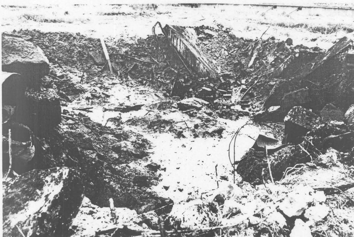
Foto 7. Ehituspraht ja metall endises kütusehoidla puhastusseadmes on määrdunud kütteõliga. Puhastusseadmes olev pinnas on läbiimbinud kütteõliga.
