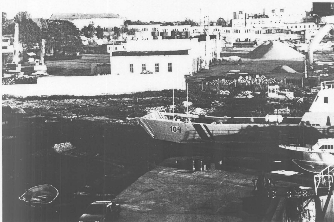
Foto 3. Fotol olevat territooriumi läbivad kaks 16 kV elektrikaablit ja AS Tallinna Vesi kuuluv 600 mm diameetriga kanalisatsiooni trass.
