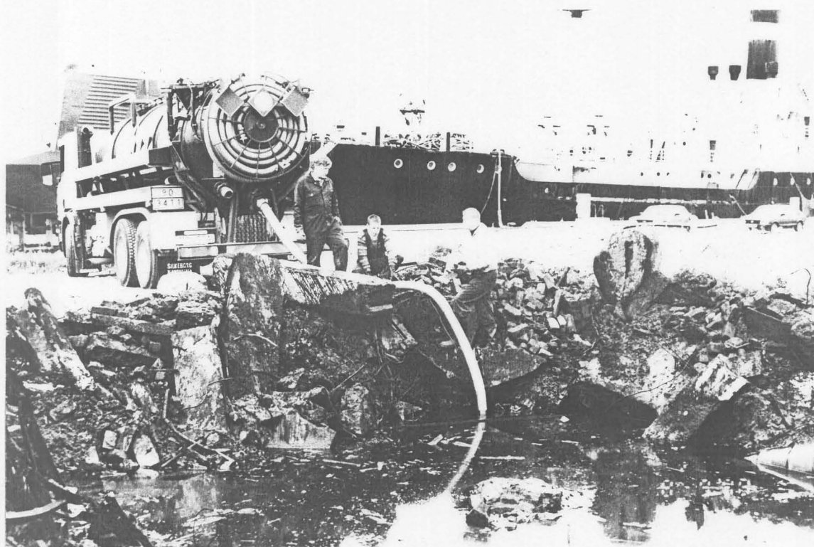
Foto 10. AS EcoPro eemaldas endisest puhastusseadmest 51 tonni kütteõli, mis utiliseeriti Eesti Elektri jaamas Narvas.
