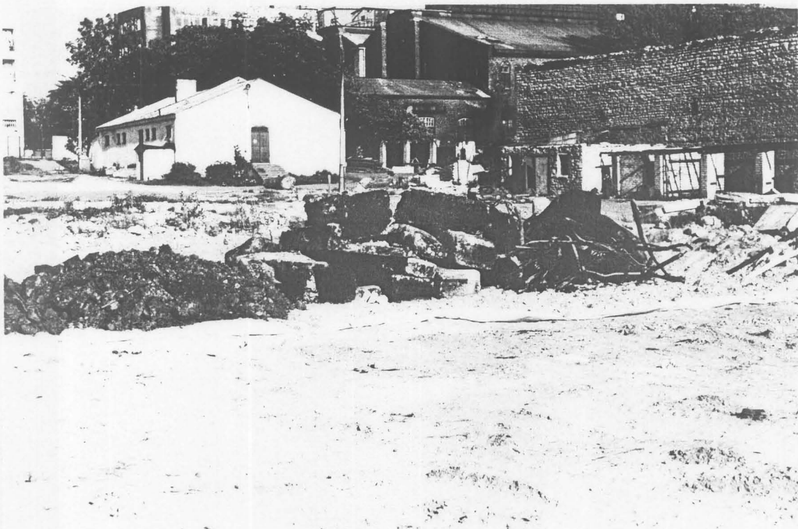
Foto 26. Nõutusplatsil selekteeriti reostunud pinnas ehitusprahist ja metallist.
