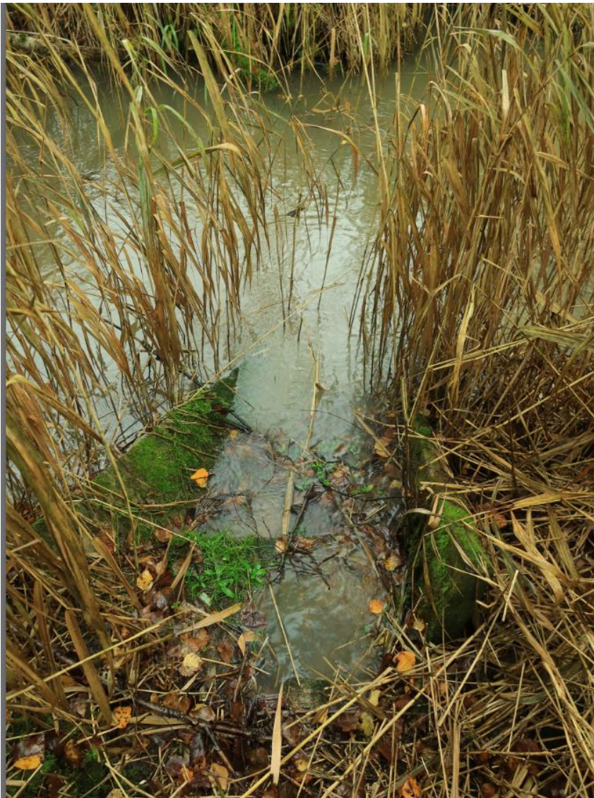
173. Kraavi paremal kaldal, kraavi veepiirist meetri kaugusel oli betoonplaatidest renn, selle otsas ca 15 cm läbimõõduga betoonist toru. Ohtralt vett voolas välja mõned cm kraavi veetasemest kõrgemal. Saaks proovi võtta:
