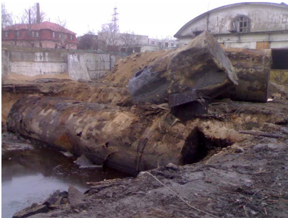
Photo 1401. Kütusehoidla vahemahutite eemaldamine 2006.
