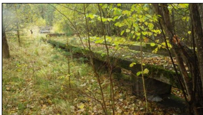
Joonis 3. Betoonist autokanal (09.10.2014)
