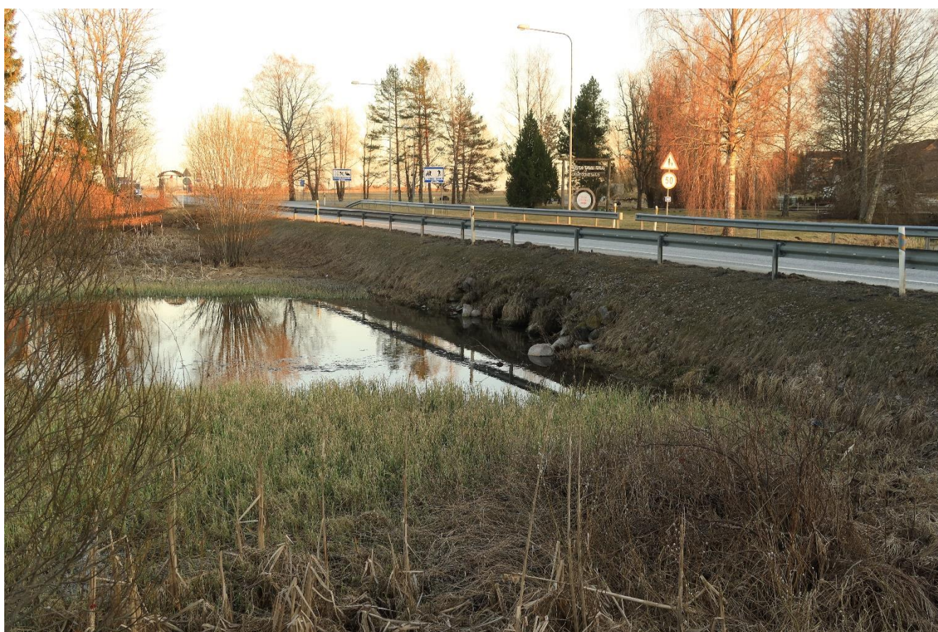
Piibe maantee all on kolm truupi, millest voolas vesi vaatluse ajal selgelt läbi. Voolu oli näha ka järves:
