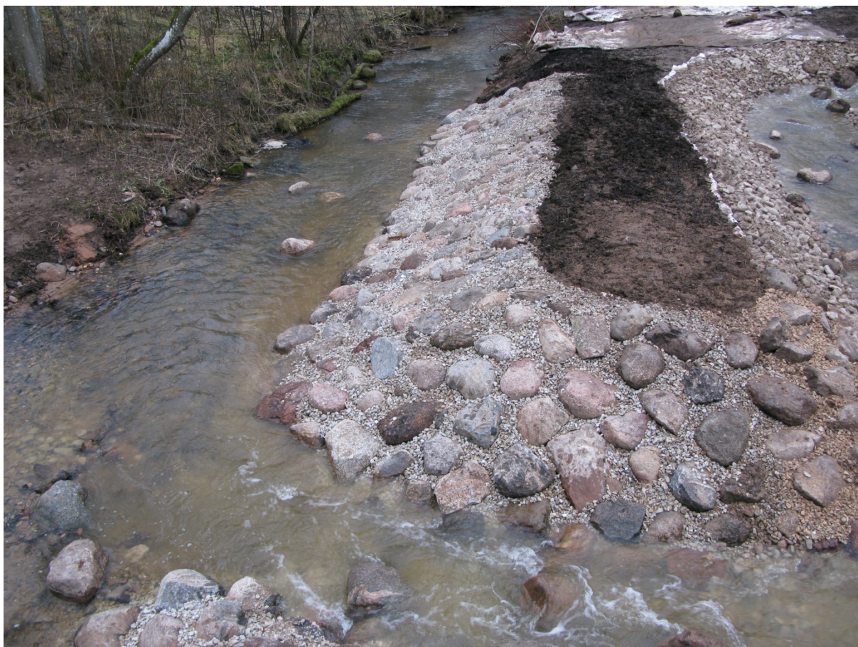
Foto 2. Vaade Piigaste kalapääsu väljavoolule. Enamus oja vooluhulgast on juhitud läbi kalapääsu ning seetõttu on kalapääsu leidmine kaldele lihtne. (M. Kesler 30.11.2015)
