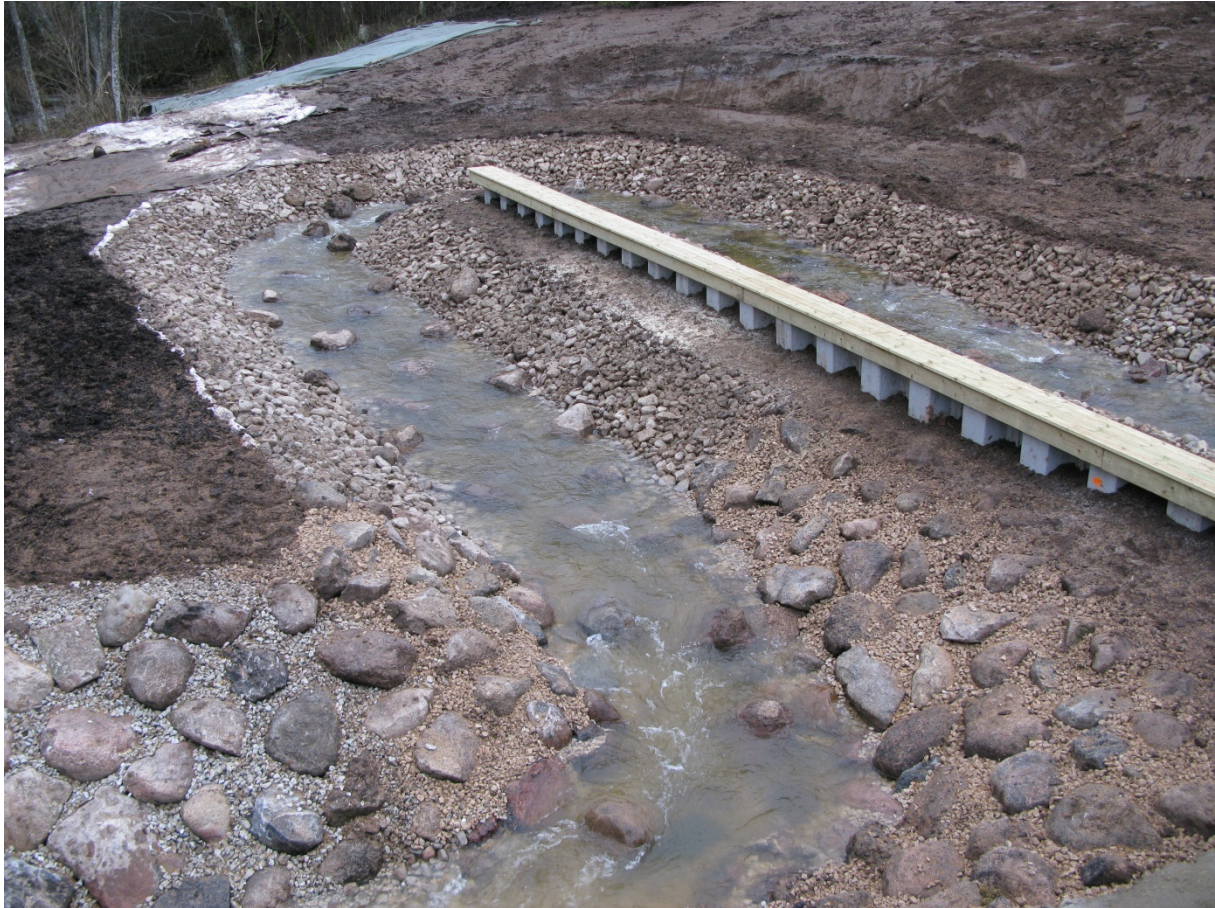
Foto 4. Voolurahustuskivide vahel on saavutatud piisavalt ühtlane lang ning pääsus ei esinenud kaladele raskesti läbitavaid kohti. (M. Kesler 30.11.2015)
