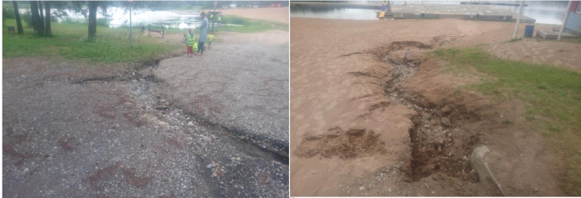
Joonis 3. Taimestiku inventuuri käigus tuvastatud tugeva vihmavalingu järel tekkinud uhtkraavid. Pilt A (vasakul) - planeeringuala lõunaservast Järve tänavalt lähtuv jalgte; pilt B (paremal) - Tartu mnt tänavalt lähtuva supelranda viiv peamine jalgte. Fotod: tehtud käesoleva töö käigus.
