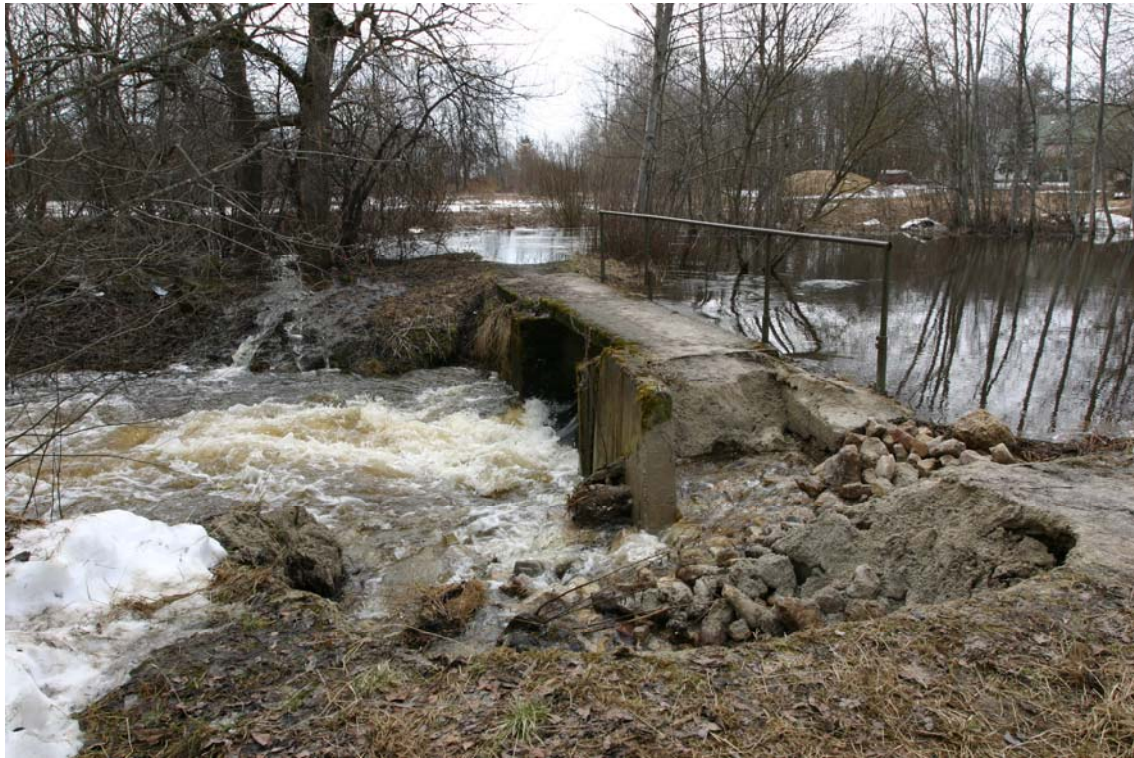
Alumise paisjärve pais on uhtud korduval suurvee perioodil ära ning seda taastatakse regulaarselt kivide ja juhuslike materjalidega
