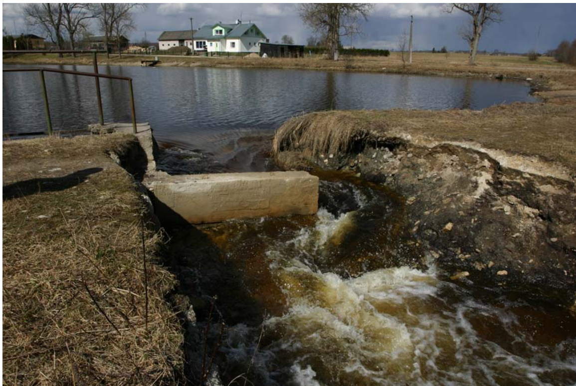
2010 aasta suurvesi uhtus ülemise paisjärve paisu lüüsregulaatori kõrvalt osa paisust minema
